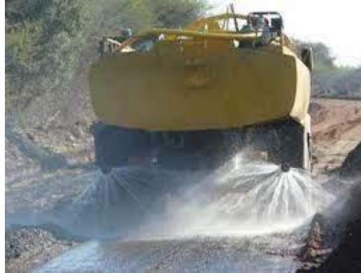
Figura 2: Riego de subrasante
