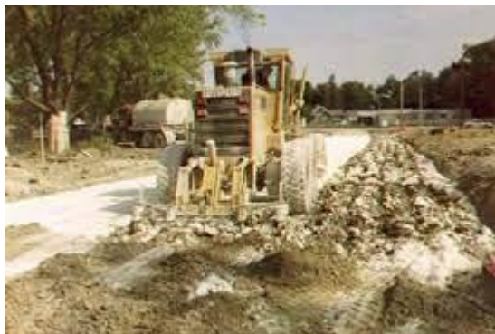
Figura 3: Combinación y tendido de la cal
