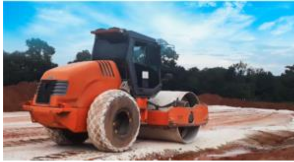
Figura 4: Compactado de la subrasante.
