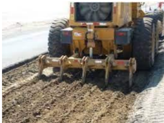
Figura 1: Escarificación de subrasante
