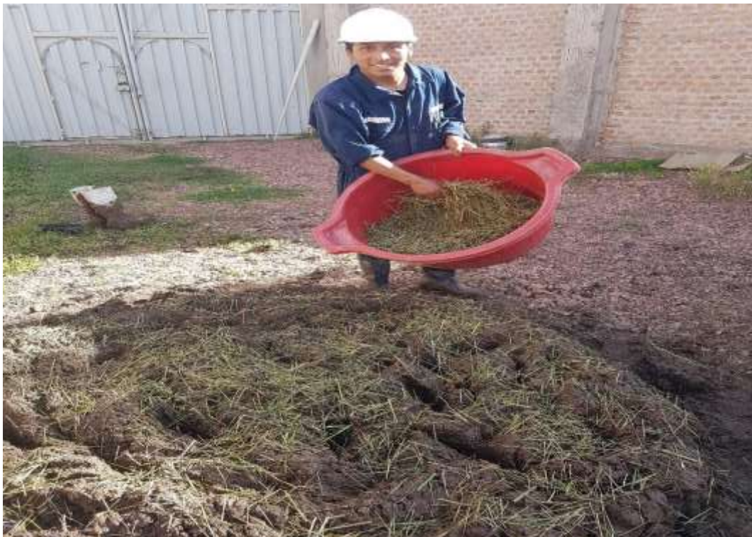
Fotografía 8: Incorporación de la totora al barro
