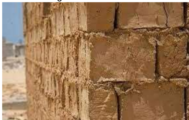
Figura 1.0 Muros de adobe
