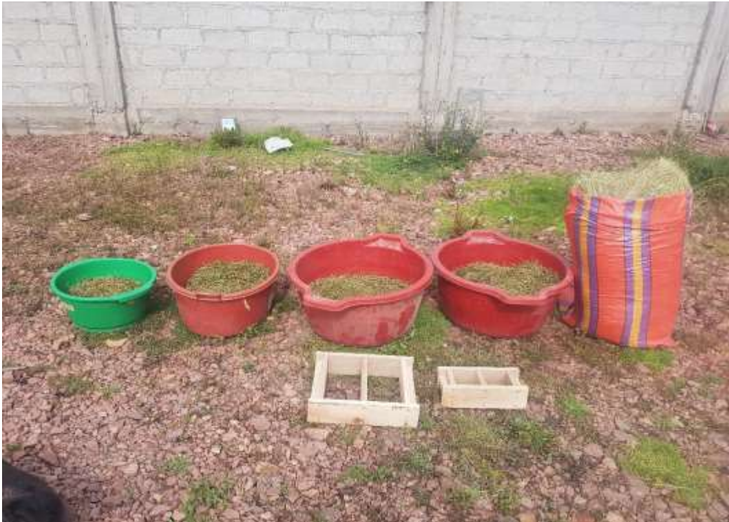
Fotografía 8: Incorporación de la totora al barro
