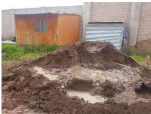
Figura 3.8 Reposo de la tierra húmedo durante 48 hrs
