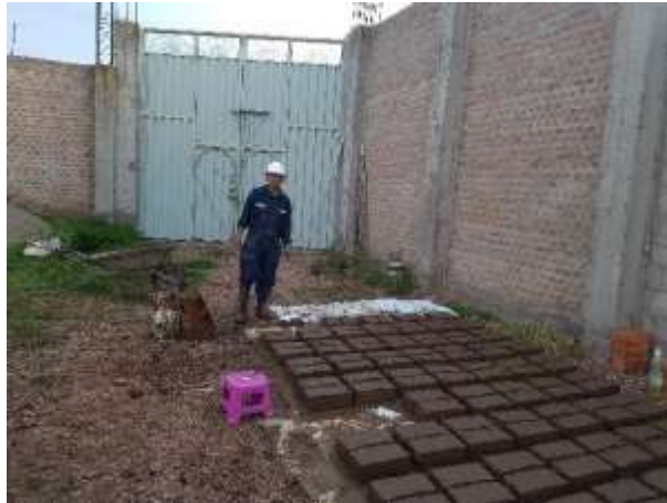
Figura 3.12 Proceso de secado de los adobes
