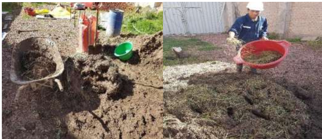
Figura 3.10 Mezcla de la tierra + totora
