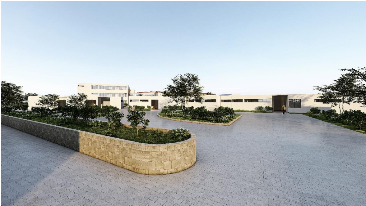
figura 109. Vista de los servicios complementarios.
