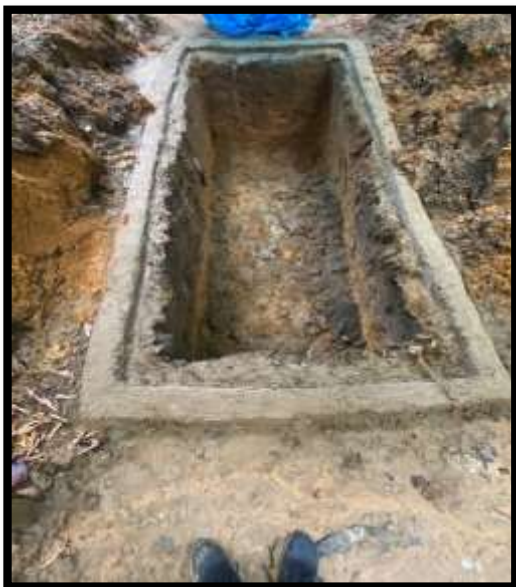
ANEXO 1: Construcción y acondicionamiento de las posas
