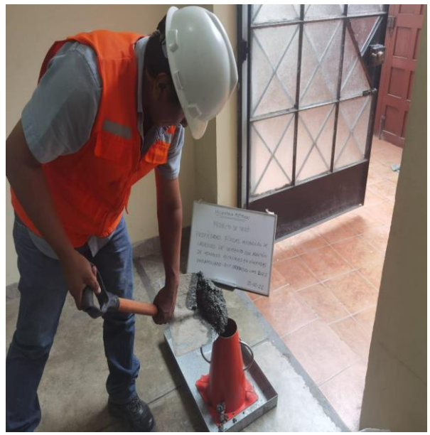
Fotografía 12: Vaciado de concreto al cono de abraham
