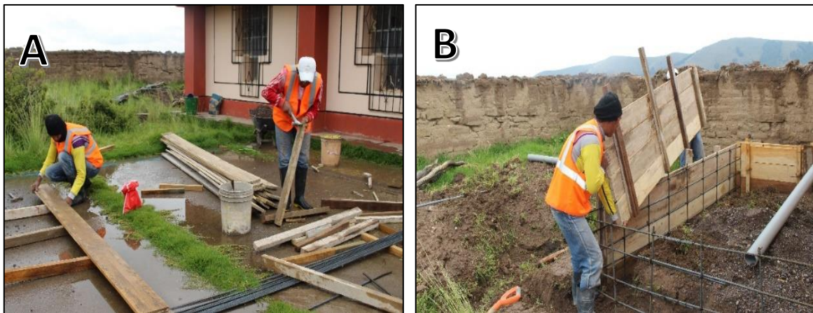
Figura 7: Encofrado del muro de contención
