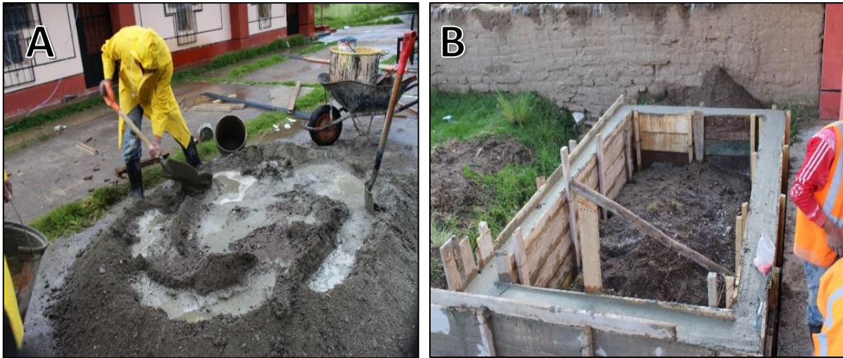
Figura 8: Muro de contención
