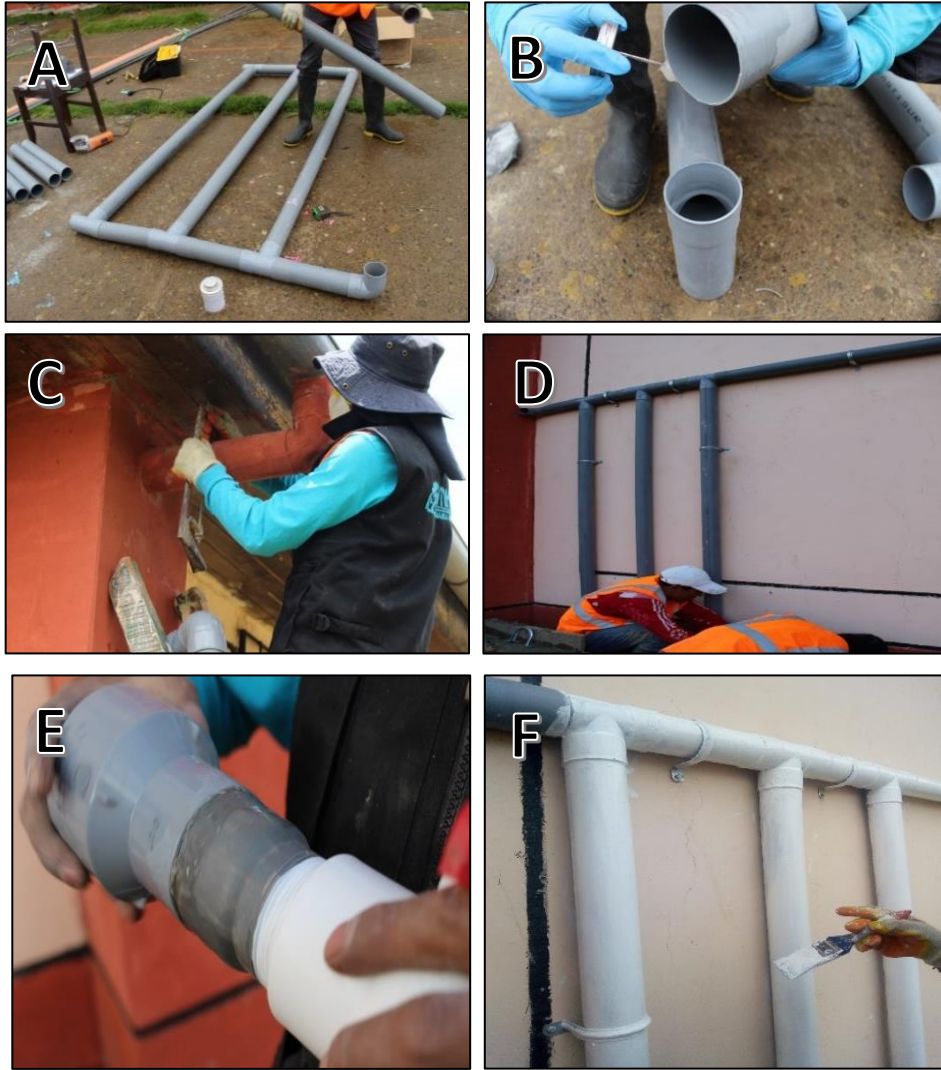
Figura 10: Interceptor de primeras aguas
