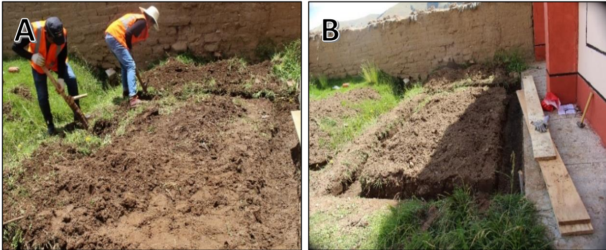
Figura 6: Limpieza del terreno para la cama de arena.
