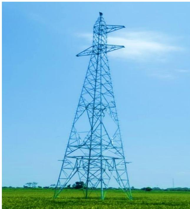
Figura 02: Estructura de acero de celosía de una línea de transmisión.
