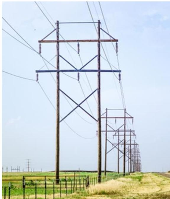
*Figura 04:* Estructura de madera con crucetas, armado tipo "H".
