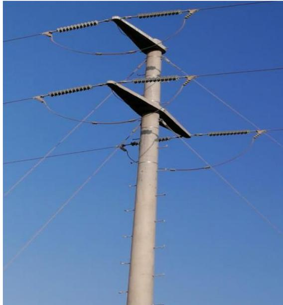
*Figura 03:* Estructura de concreto armado con cruceta y ménsula.
