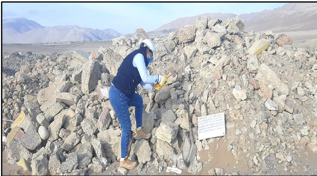
Selección y recojo de los Residuos de Demolición y Construcción
