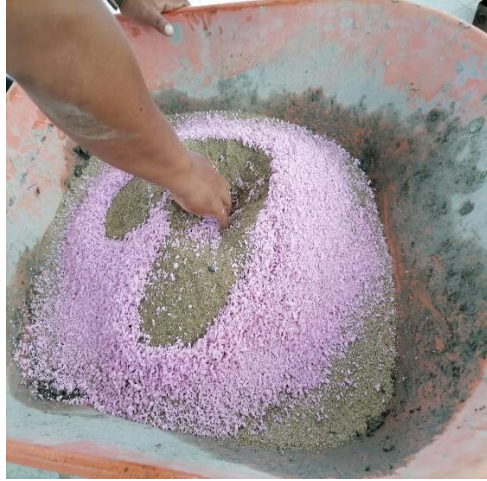
Figura N° 53 Añadiendo Poliestireno Extruido
