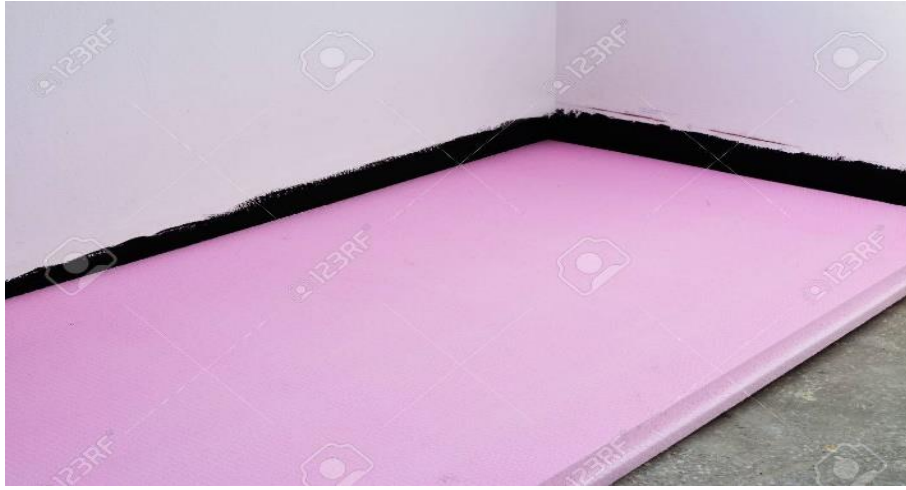
Figura 40. Planchas de espuma de poliestireno extruido para aislamiento térmico.
