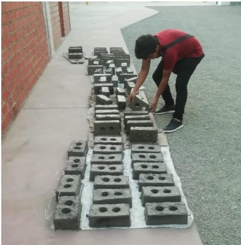
Volanteando los ladrillos para el secado completamente expuesto al sol. Elaboración propia.
