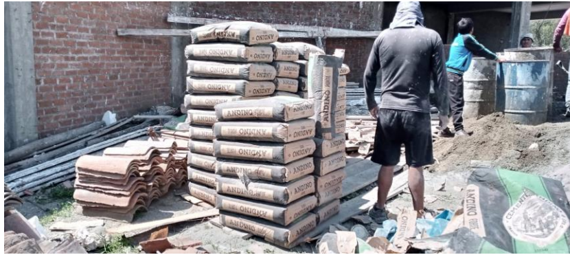
Figura 9 Almacenamiento de cemento – Vivienda 4
