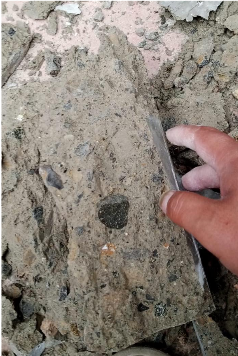
Figura 56 vista interna del concreto endurecido-vivienda 1
