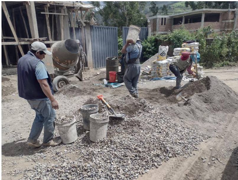
Figura 11 Vivienda N° 2 almacenamiento de materiales
