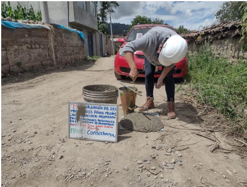
Figura 13 Vivienda N° 2 Ensayo de Asentamiento
