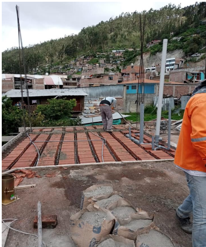
Figura 4 Vivienda N° 1 Concreto utilizado en losa Aligerada
