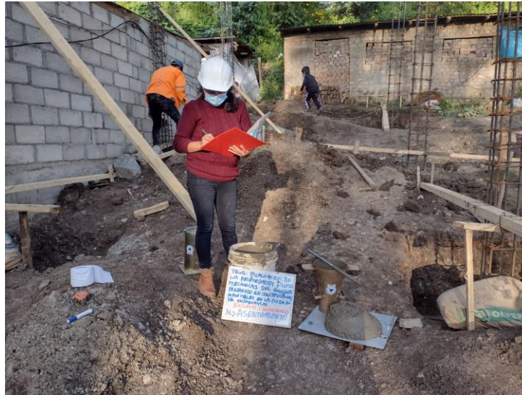
Figura 6 Vivienda N° 3 Concreto utilizado en Zapata
