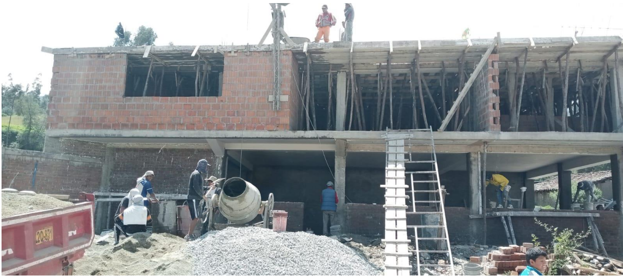
Figura 7 Vivienda N° 4 Concreto utilizado en losa Aligerada
