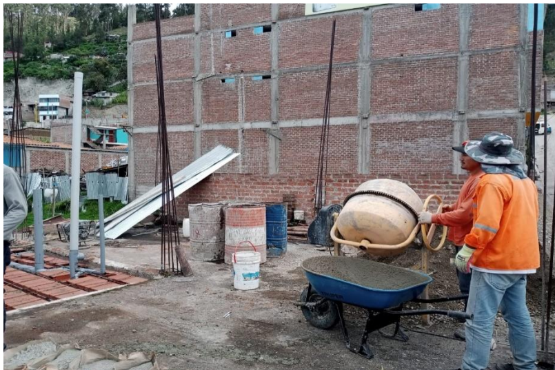
Figura 10 Vivienda N° 1 almacenamiento de materiales
