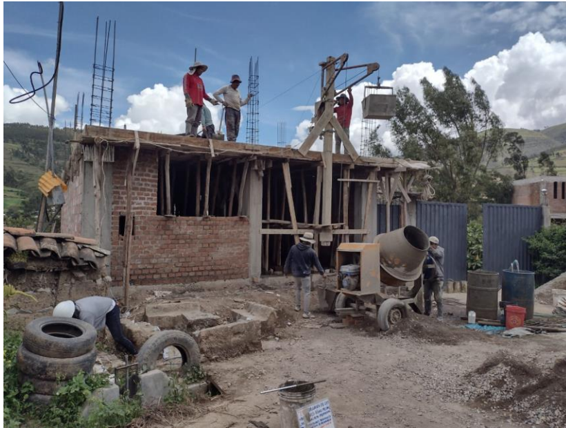
Figura 5 Vivienda N° 2 Concreto utilizado en losa Aligerada
