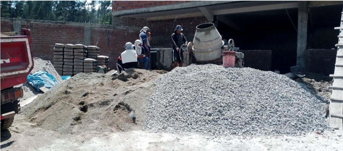
Figura 12 Vivienda N° 4 almacenamiento de materiales
