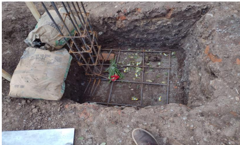
Figura 1 Armado de acero en zapata en una construcción informal.
