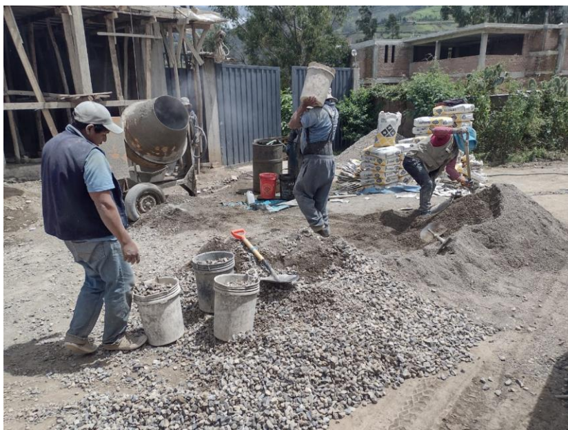
Figura 8 Almacenamiento de agregados – Vivienda 2
