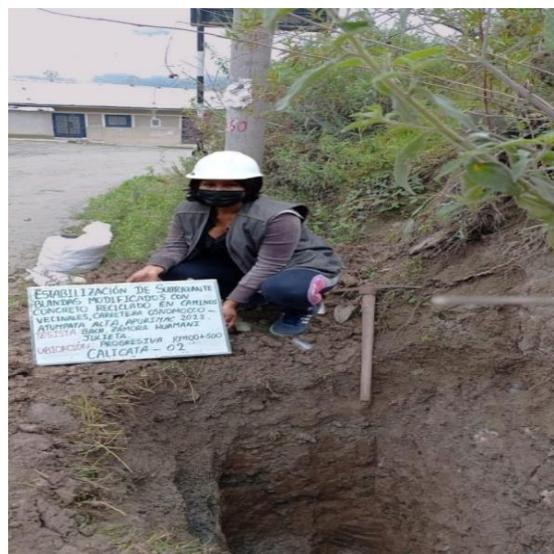
**Figura 3.3.** Extracción de muestra natural, calicata 02 Km 00+500
