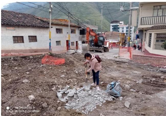
**Figura 3.6.** Trituración del concreto reciclado manual
