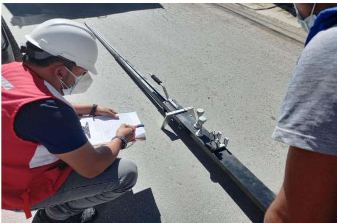
Figura N°08: Toma de lecturas de la viga Benkelman en carril DERECHO de la zona de pendiente n°03
