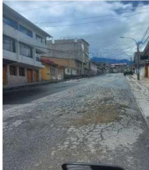
**Figura 2** Fallas en el pavimento
