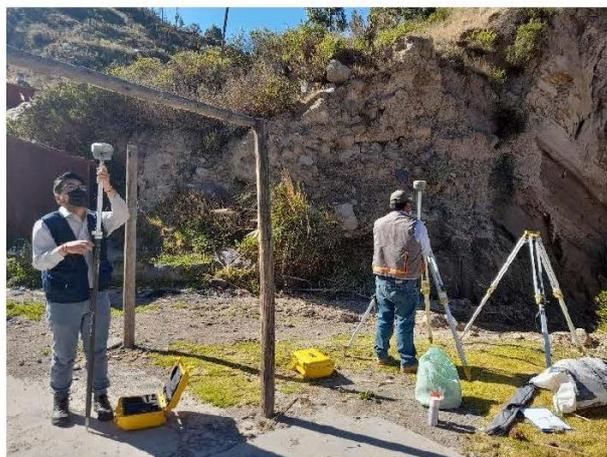
*Imagen: 3 Levantamiento topográfico*
