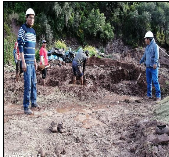
Fotografía 08: pisado del barro después de 48 horas
