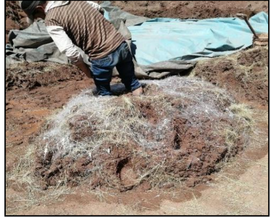
Fotografía 22: Mezclado del barro con los residuos de protectores faciales
