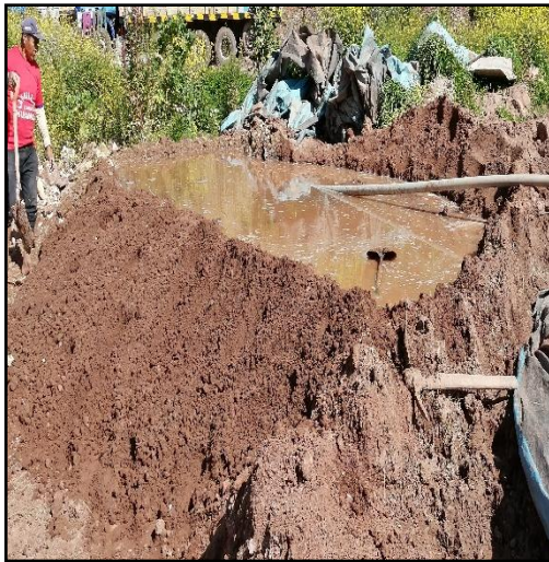
Fotografía 07: Preparación del barro
