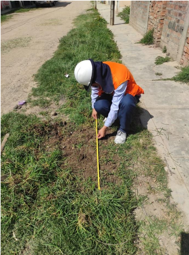
Imagen 3: Midiendo el ancho de la calicata
