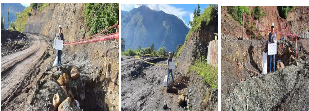
Figura 09. Calicatas en sitú C-04, C-05 y C-06
