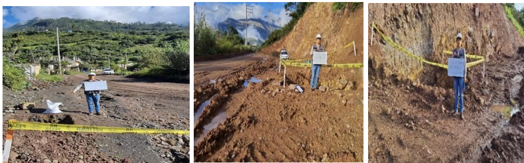
Figura 08. Calicatas en sitú C-01, C-02, y C-03
