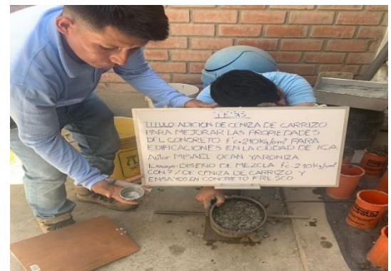
Foto 10: Ensayo de Saturación de Concreto.
