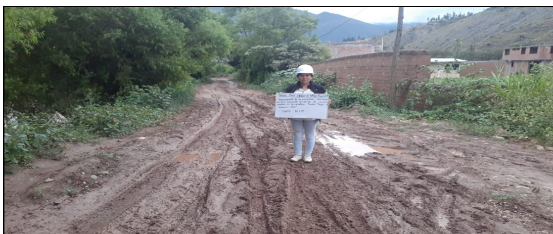
Estado de carretera Predio Tingo Km+002 después de lluvias
