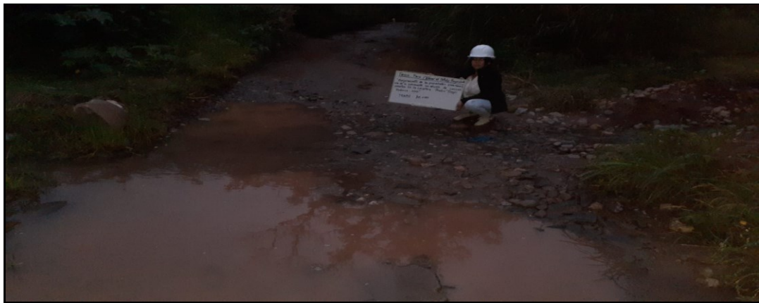
Empozamiento de agua en tramo Km0+800
