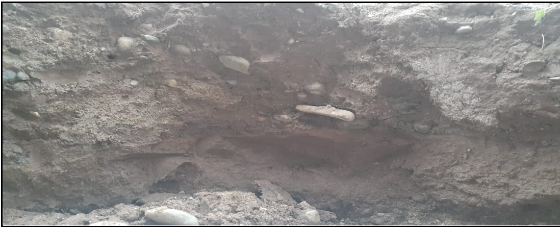
Capas de suelos de Calicata 02 realizada en Km2+300
