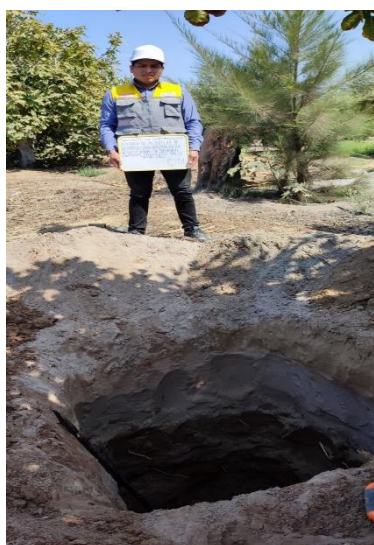
Figura 10. Excavación de Calicata - 01
