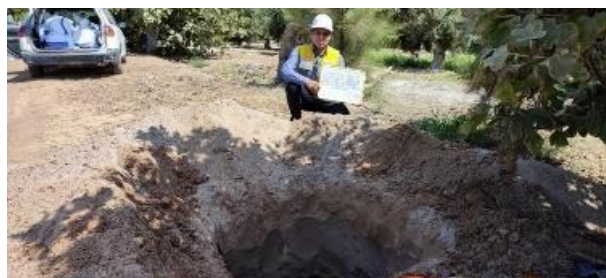
Figura 12. Excavación de Calicata - 03
