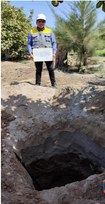
Elaboración de calicatas
