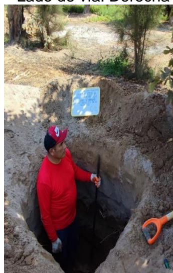
Figura 11. Excavación de Calicata - 02
