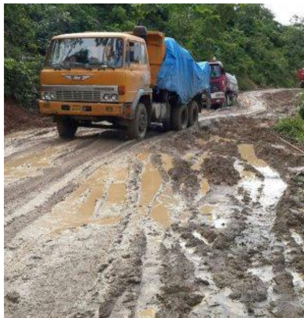
Figura 7. Drenaje inadmisibile.
