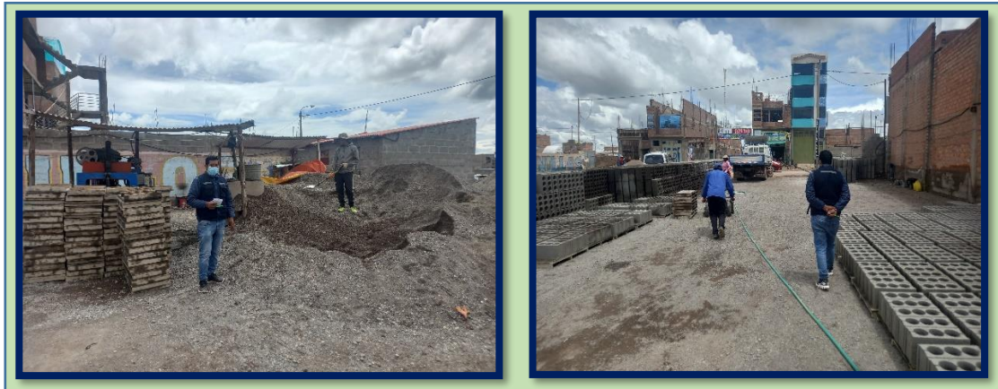
Figura 14. Lugar donde fabrican bloques de concreto Fuente: Elaboración propia
