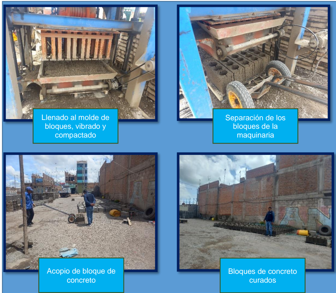
Figura 17. Llenado, compactado y acopio de bloques de concreto Fuente: Elaboración propia
