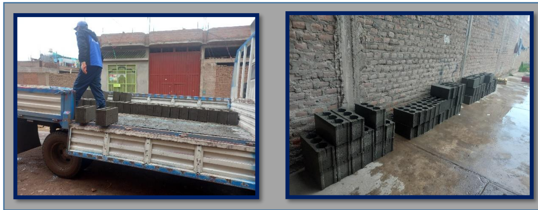
Figura 18. Traslado de bloques de concreto Fuente: Elaboración propia
