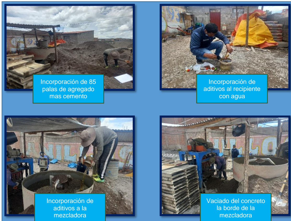
Figura 16. Preparación de concreto para elaboración de bloques de concreto Fuente: Elaboración Propia
