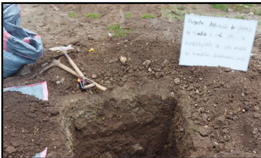
Fotografía N° 02: Exploración mediante calicata en el tramo en investigación, Av. industrial – Andahuaylas, 2022
