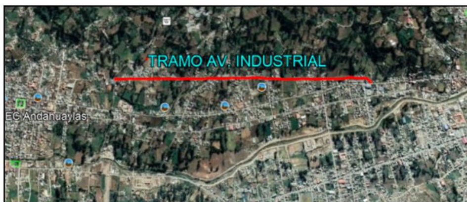
Figura 5. Vista del tramo en investigación
