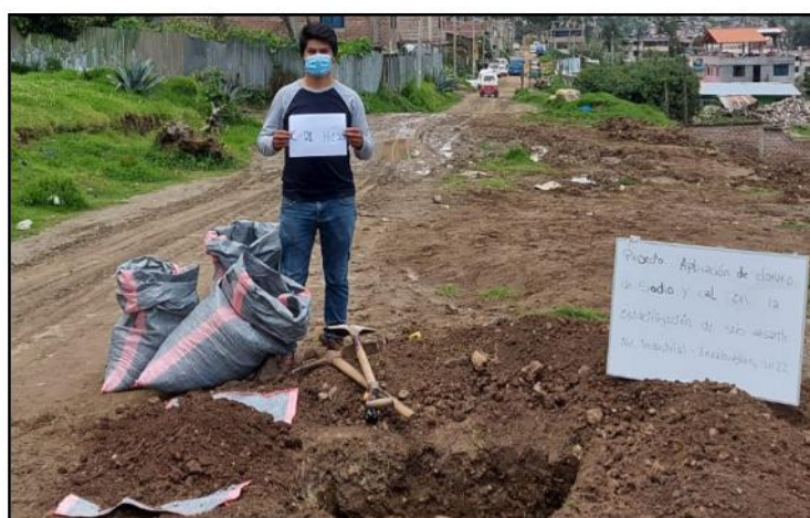
Figura 6. Vista de la realización de la calicata
