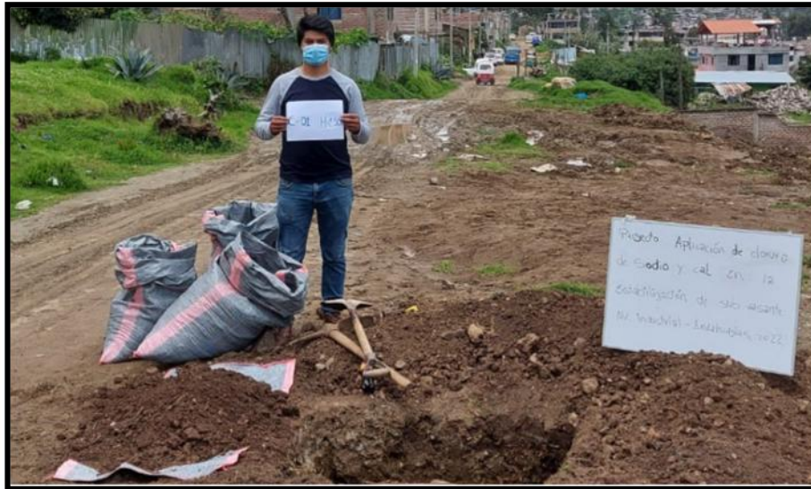
Fotografía N° 01: Exploración mediante calicata en el tramo en investigación, Av. industrial – Andahuaylas, 2022
