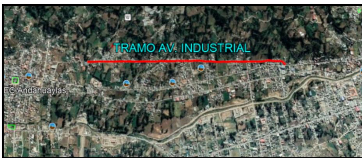
Figura 5. vista del tramo Av. industrial
