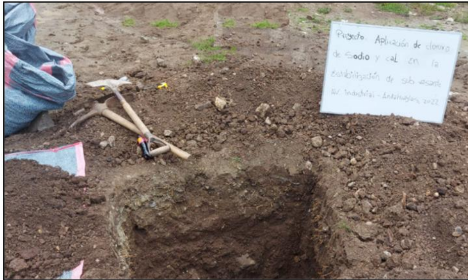
Figura 7. Vista de la realización de la calicata
