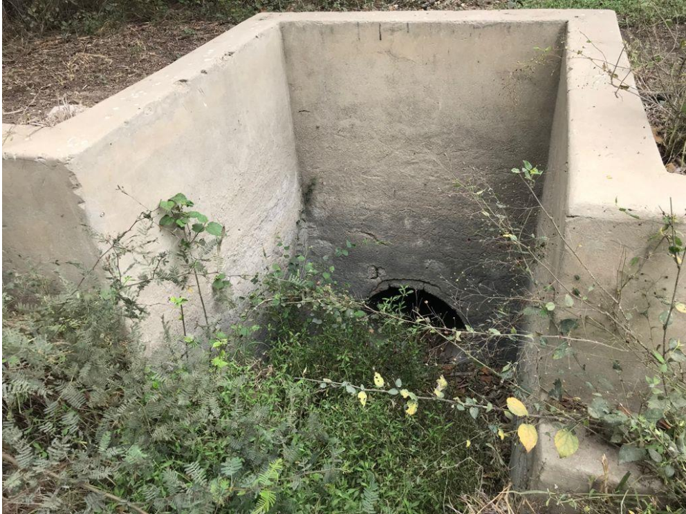
Figura 25. Alcantarilla cajón encontrada
