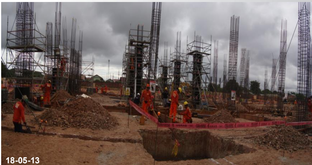
Sector Tottus – Habilitado de acero en Vigas de Cimentación
