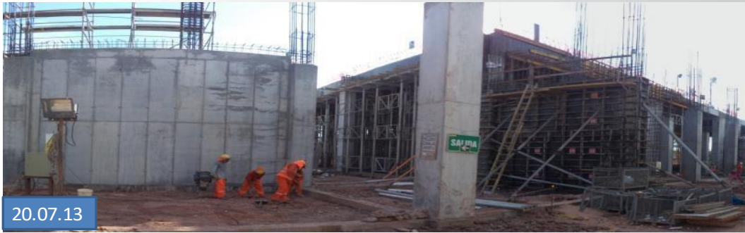
Frente III: Encofrado de vigas y losa
