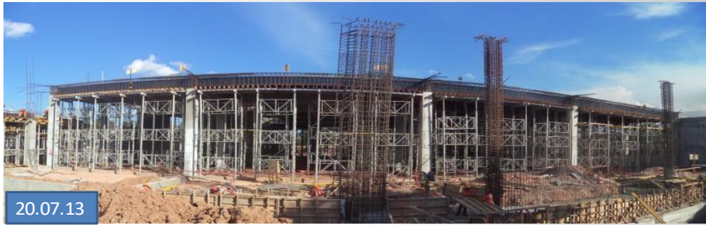
Frente II ( Patio Constructor ) Avance en Encofrado de losa
