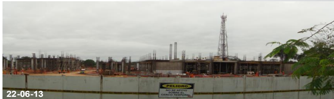
Frente 02: Vista de Avance en vigas y losas de techo
