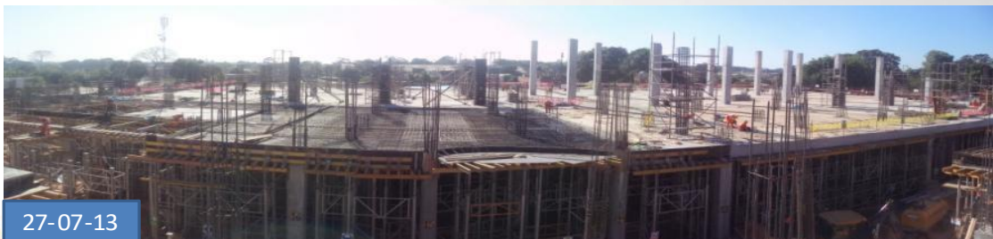
Avance de Vaciado de concreto y habilitación de acero en losa en Fronte I (Tottus)
