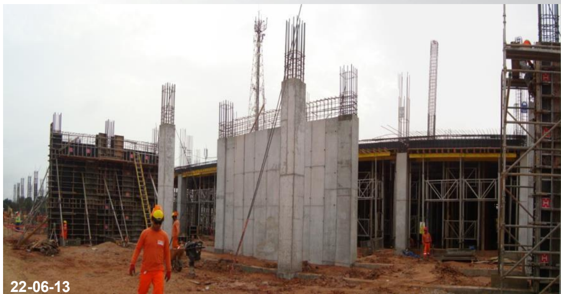
Frente 02: Encofrado de placas en sector 4 (Tottus)
