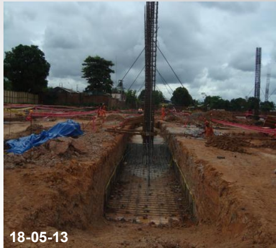
Sector Patio Constructor – Vaciado de Solado y Habilitación de acero en Columnas
