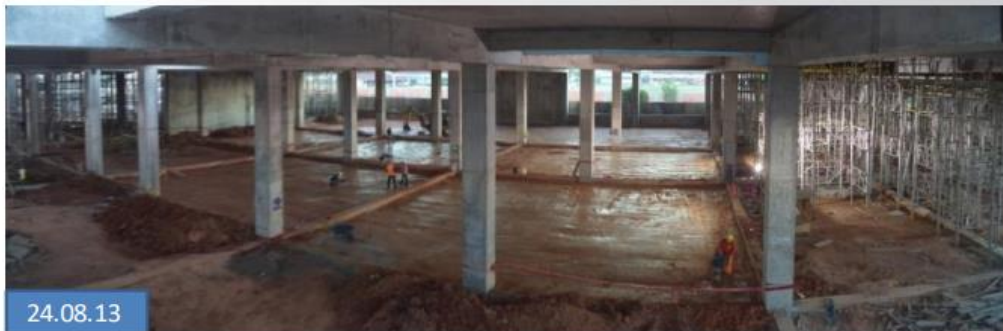
FRENTE II – Afirmado y compactado de sector de Patio Constructor
