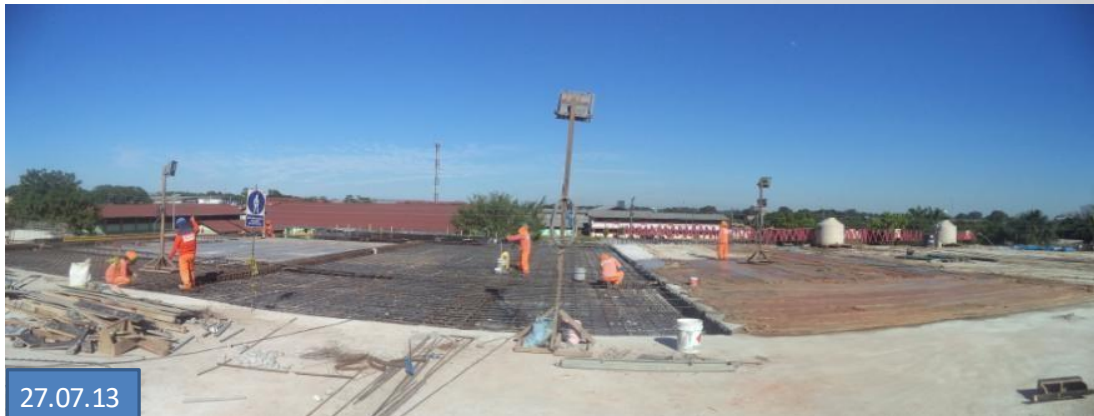
Frente II: (Eje N-15.1) Habilitación de acero y encofrado en losa de Patio Constructor
