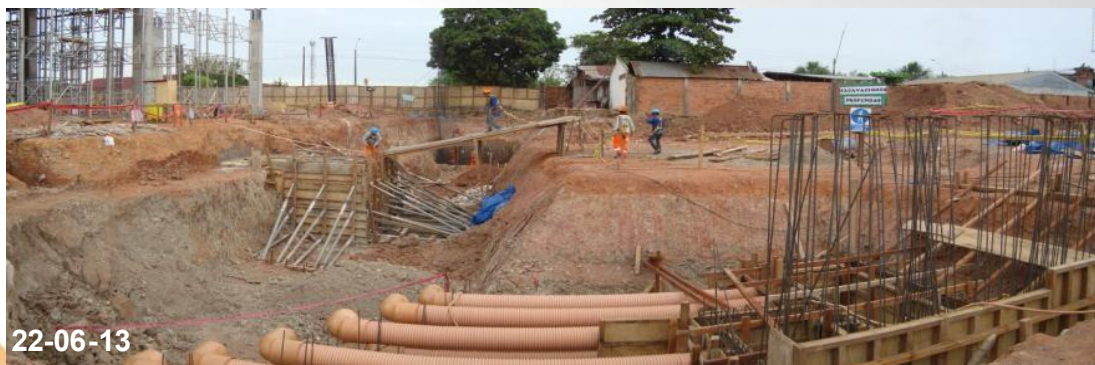
Colocación de Tuberías ,habilitado de acero y Encofrado en cárcamo B
