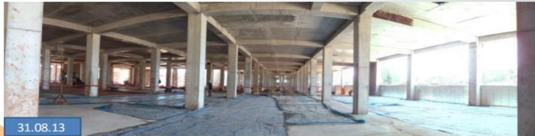
FRENTE I (Tottus): Vaciado de losa de piso
