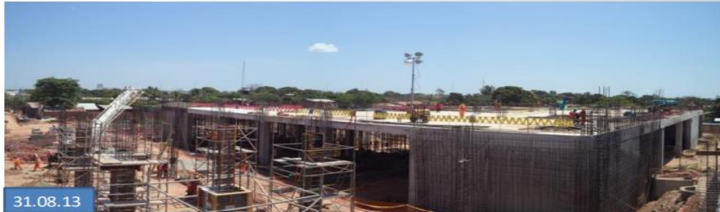
FRENTE IV: Vaciado de losa de techo
