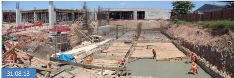
FRENTE IV : Vaciado de concreto en cisterna.
