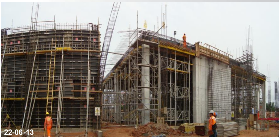
Frente 02: Encofrado de placas en sector 8
