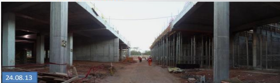
FRENTE II: Desencofrado de losas y columnas del sector GALERIAS
