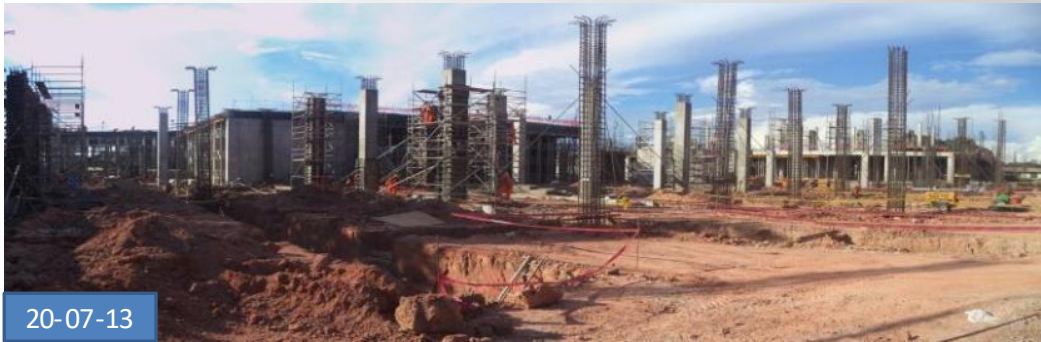
Frente II (Patio Constructor)- Habilitación de acero y encofrado en columnas
