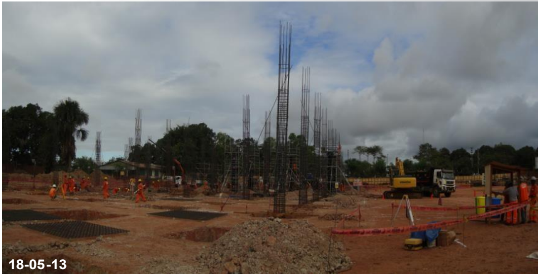
Sector Tottus – Habilitación de Acero en Zapatas y Izaje de Columnas de Acero
