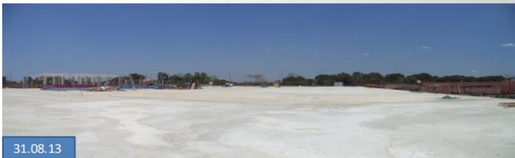
Sodimac y Patio Constructor: vaciado de losa de techo
