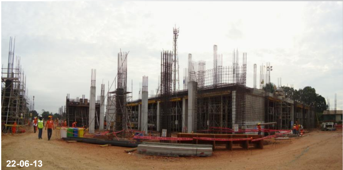
Frente 01: Vaciado de Losa de techo sector Tottus
