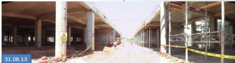
FRENTE II: Desencofrado de losas y columnas del sector GALERIAS
