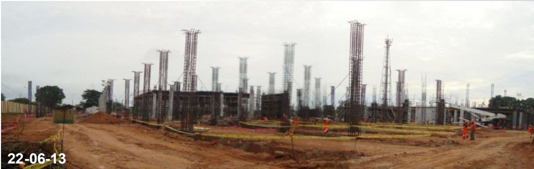
Sector Patio Constructor- Habilitación de acero y encofrado en columnas
