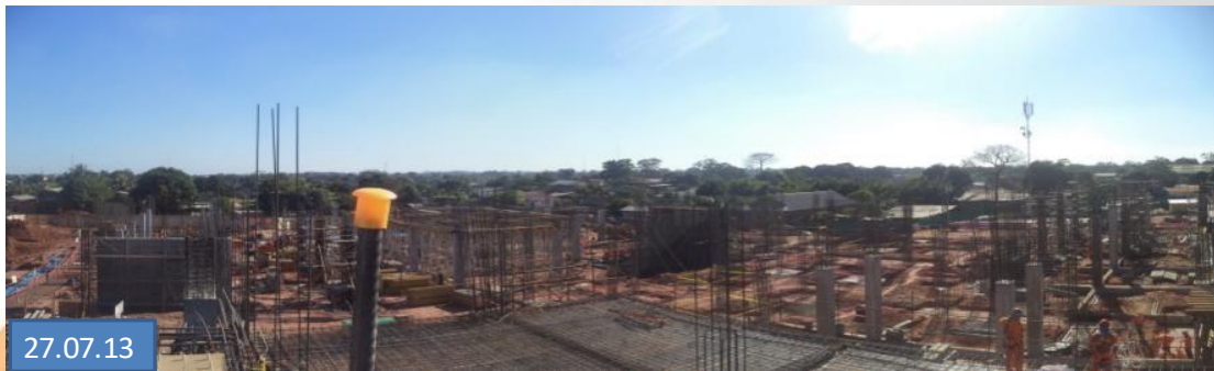
Frente IV: Vaciado de zapatas y habilitación de columnas
