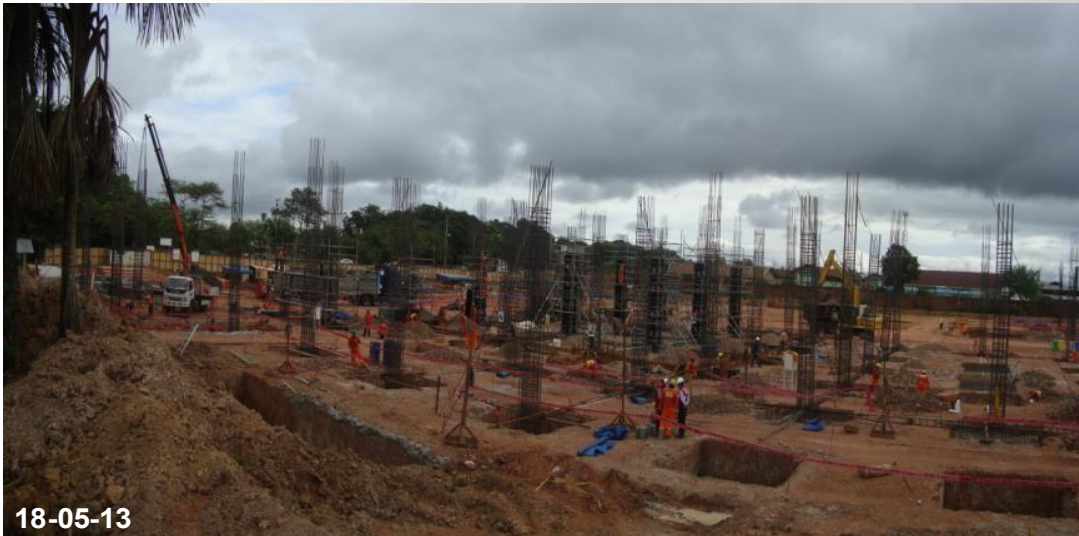
Sector Tottus – Excavación de Zapatas, Vaciado de solados y Izaje de Columnas de Acero
