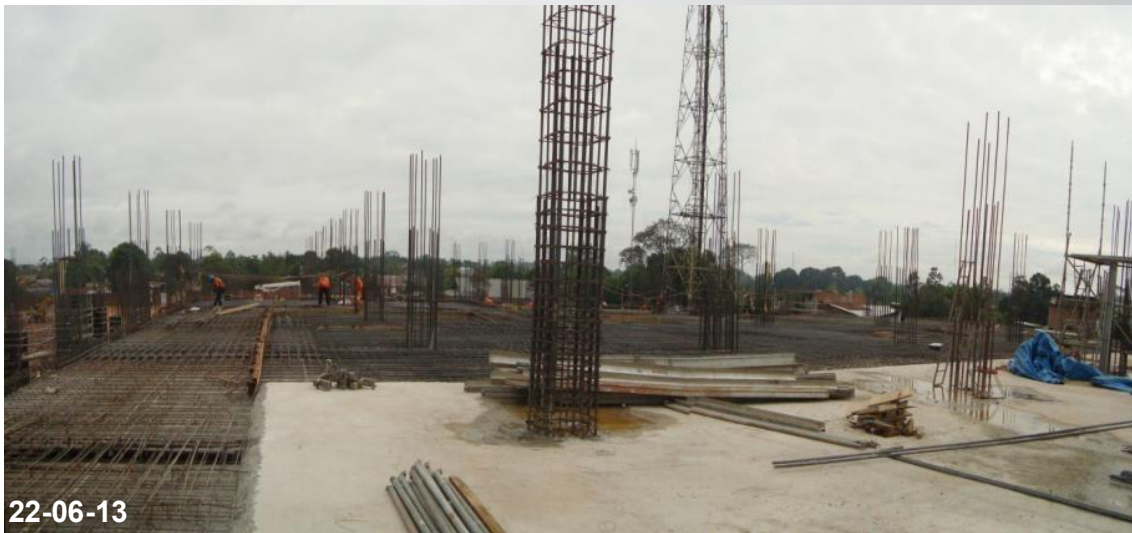
Losa de Tottus, Encofrado y Habilitado de Acero
