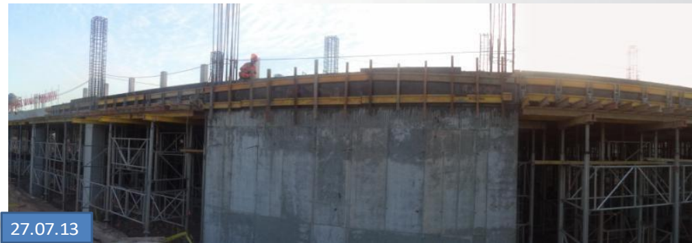
Avance de Encofrado de vigas y losa de techo
