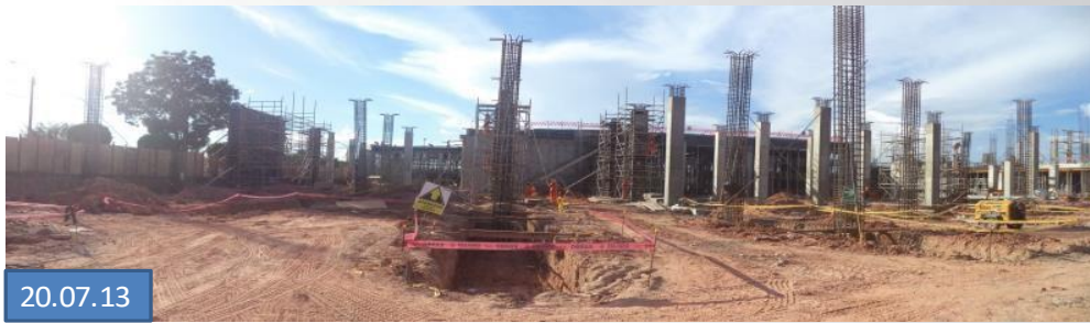
Frente II (SODIMAC)– vaciado de columnas
