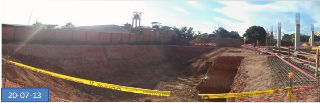
Excavación en sector IV – Cisterna
