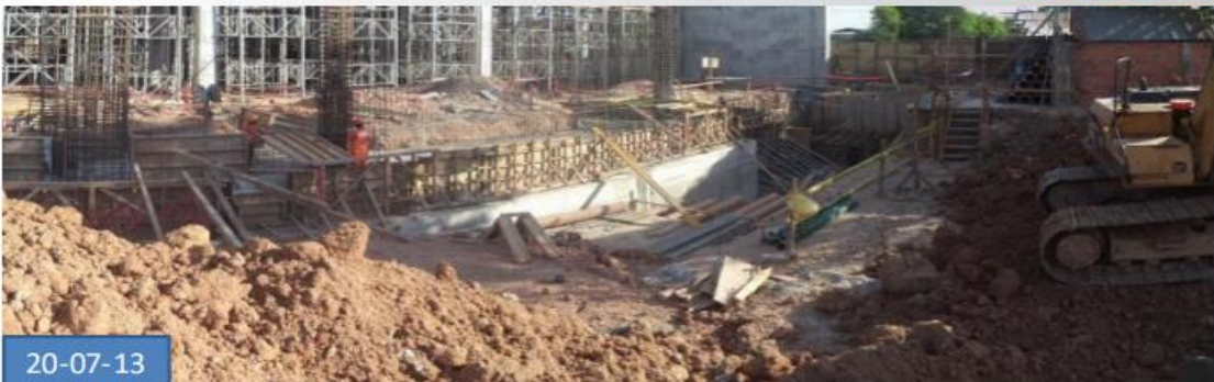
Enterrado de Tuberías ,habilitado de acero y Encofrado en cárcamo A
