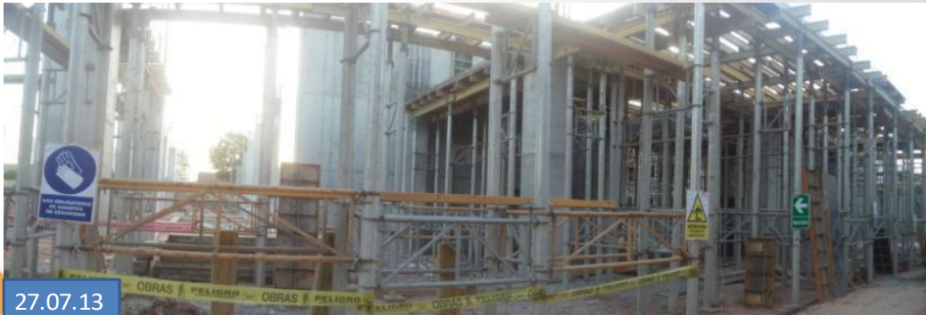
Frente III: Encofrado de vigas y losa
