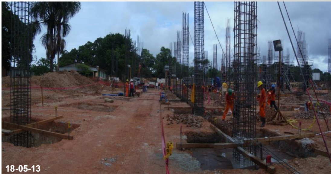
Sector Tottus – Vaciado de Concreto de Zapatas y Izaje de Columnas
