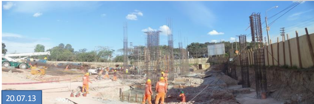
Frente III ( BANCOS )- habilitación de acero y vaciado de zapatas
