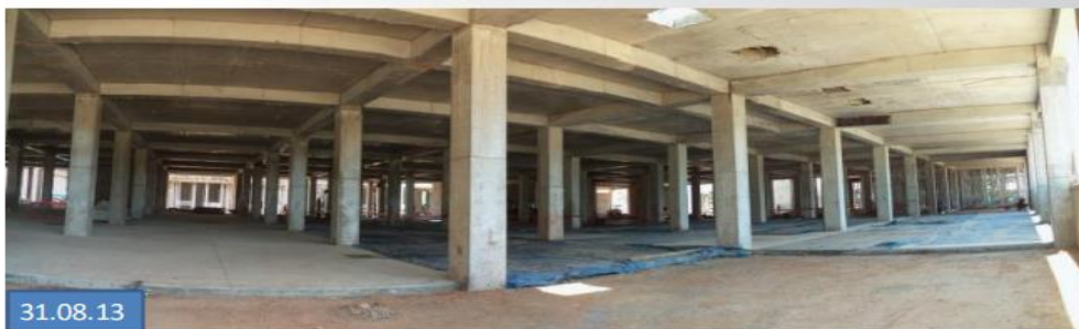
FRENTE I: Vaciado de losas de piso TOTTUS
