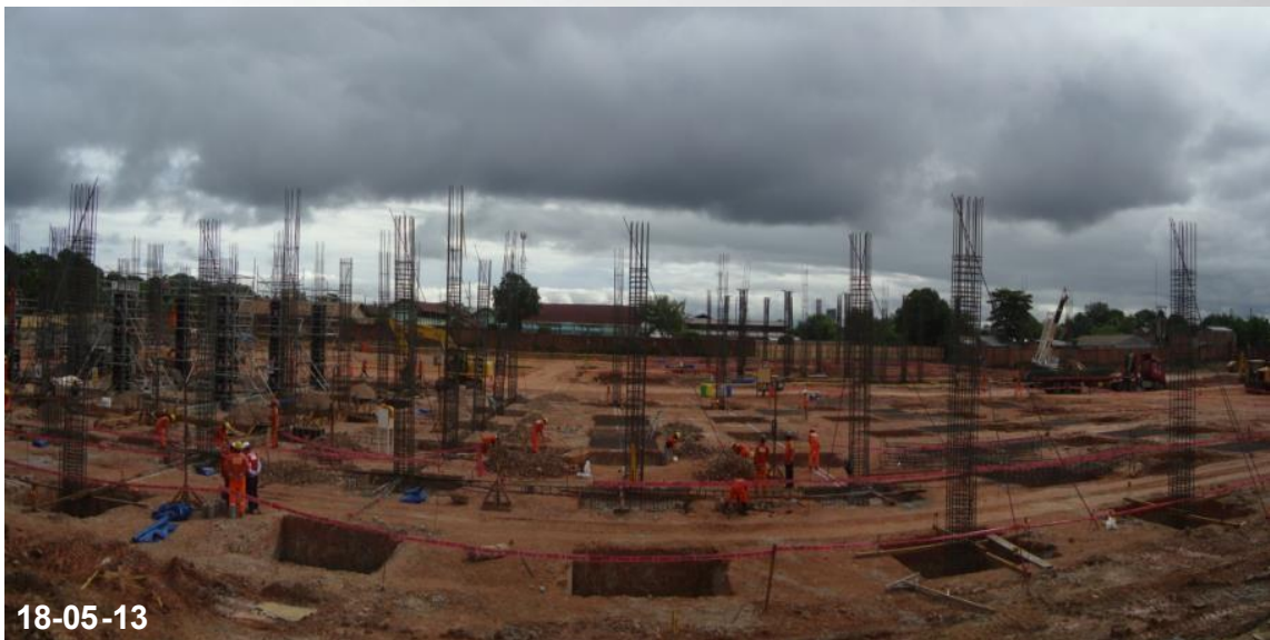
Sector Tottus - Excavación localizada en zapatas, Solado y Izaje de Columnas Acero
