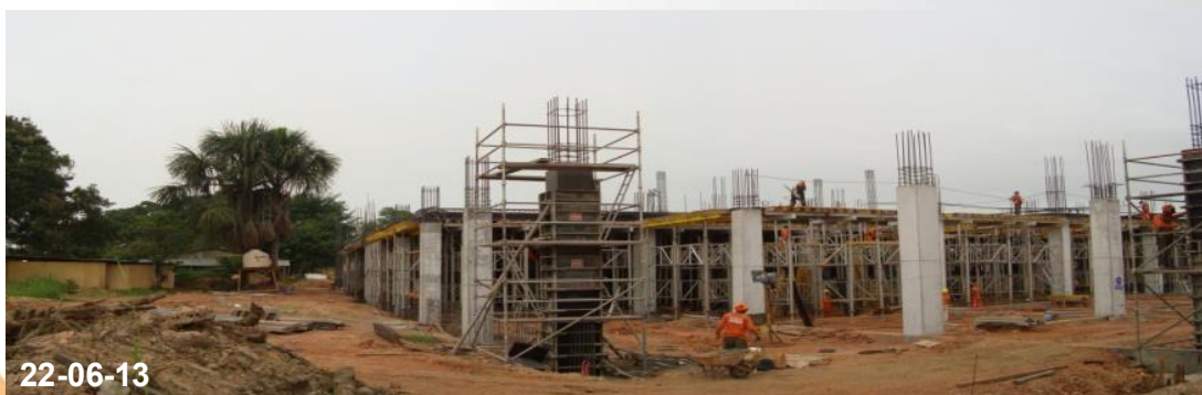
Sector Tottus: Vaciado de Zapatas y Encofrado de Columnas
