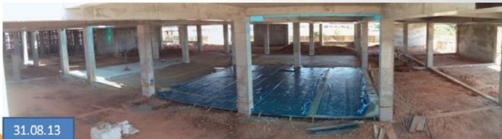
FRENTE II – Afirmado y compactado de sector de Patio Constructor
