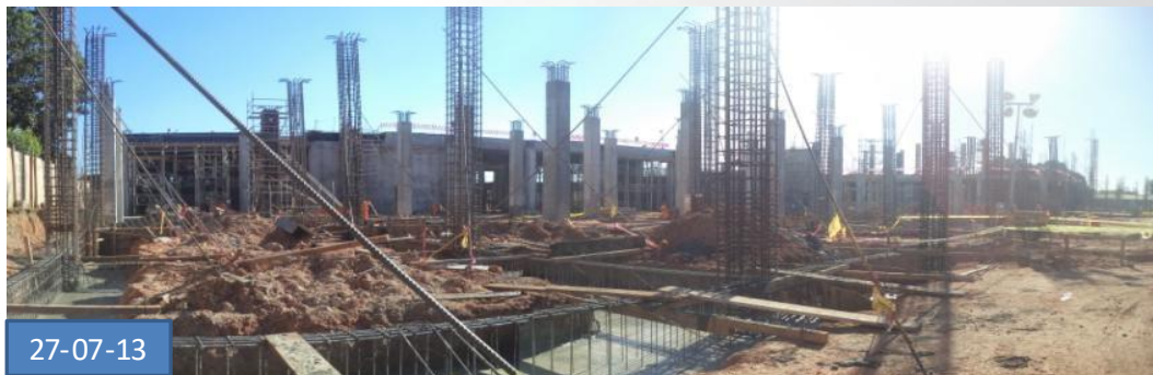
Frente II (Patio Constructor)- Habilitación de acero en columnas y vaciado de slabs
