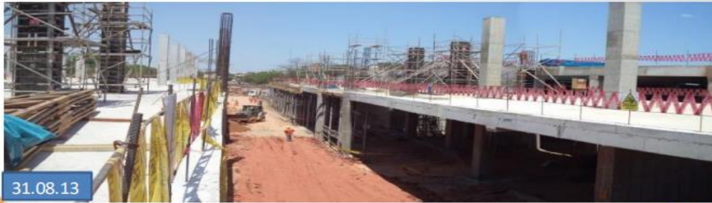
FRENTE II: Vaciado de columnas en Sector de Galerías
