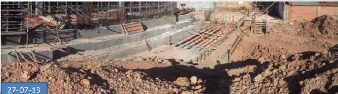
Enterrado de Tuberías ,habilitado de acero y Encofrado en cárcamo A
