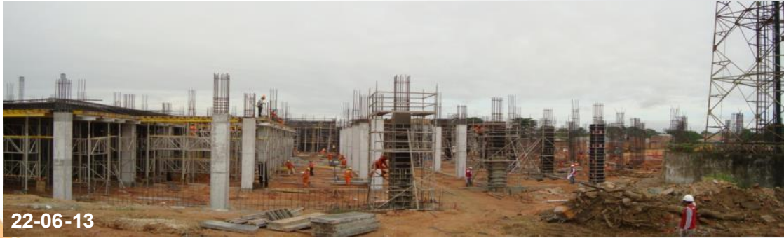
Sector Tottus- Encofrado y vaciado de concreto en columnas
