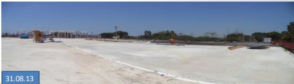
FRENTE II: (Entre Eje 10.1 -11.1) Vaciado de losa de techo en SODIMAC
