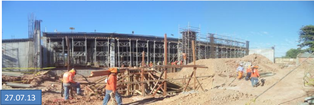
Frente II ( Patio Constructor ) Avance en Encofrado de losa y encofrado de columnas
