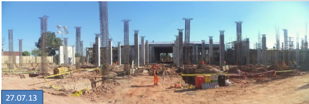
Frente II (SODIMAC)– habilitación de acero en columnas
