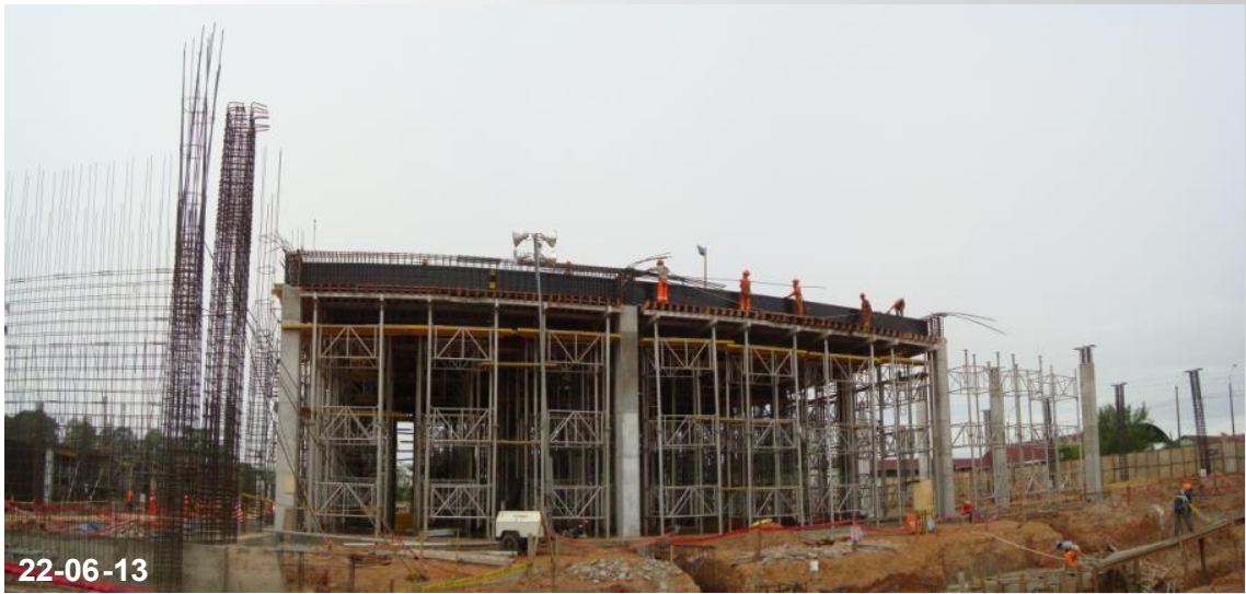
Frente 02: Encofrado de Losa en sector 8
