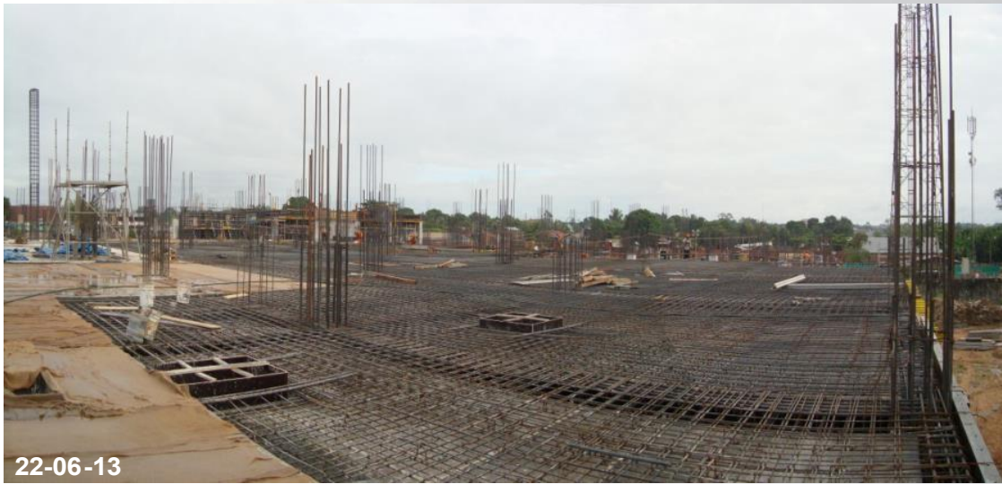
Losa de Tottus, Habilitado de Acero.
