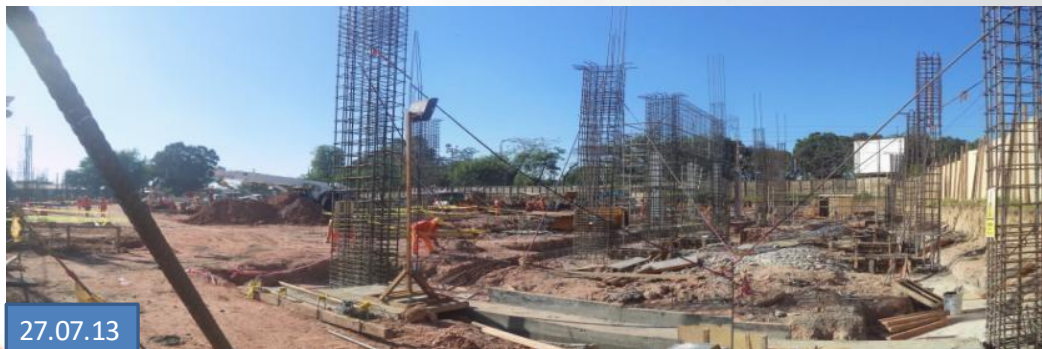
Frente III ( BANCOS )- habilitación de acero y encofrado de vigas de cimentación
