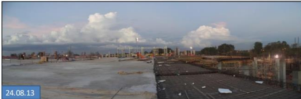
FRENTE II: (Entre Eje 10.1 -11.1) Vaciado de losa de techo en SODIMAC
