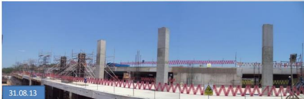
Galerías : encofrado de columnas y vaciado de losa de techo
