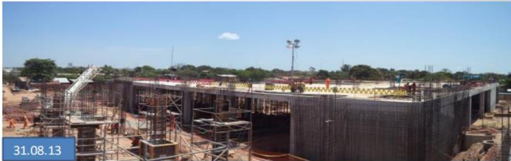
Tiendas Intermedias : encofrado de columnas
