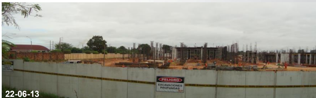
Frente02- Vista de Avance en habilitación de acero y vaciado de columnas
