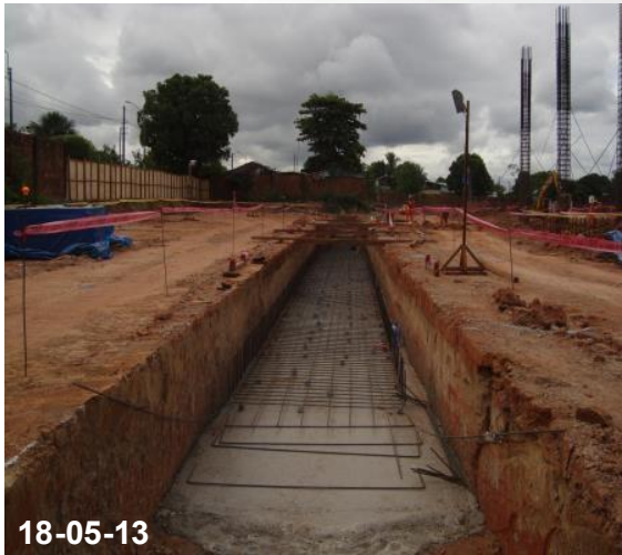
Sector Patio Constructor – Vaciado de Solado y Habilitación de acero en Columnas
