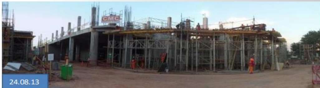
FRENTE I: Vaciado de zapatas y habilitación de acero en columnas en Restaurantes
