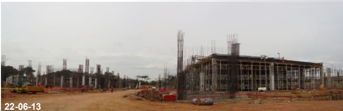
Sector Patio Constructor- Vaciado de concreto en placas, columnas y zapatas
