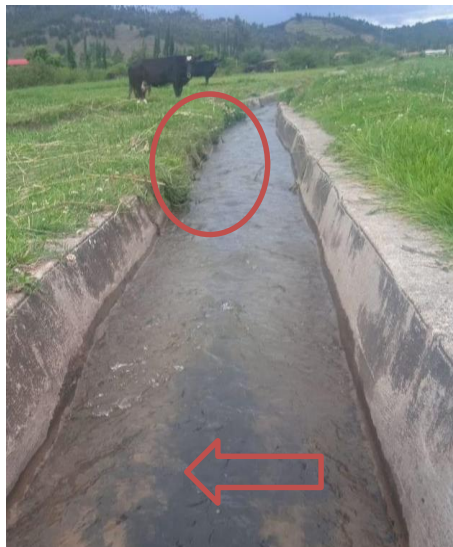
Figura 8: Canal con presencia de vegetación
