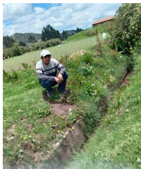
Figura 10: Presencia de vegetación en el canal de riego
