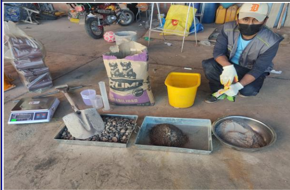
Foto 9. Pesado de los material, antes de dar innicio con el mezclado.
