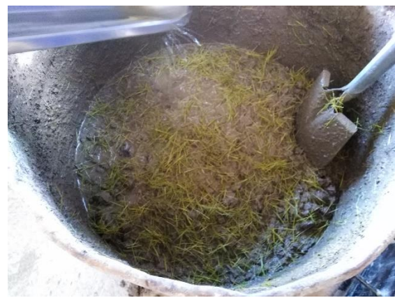
Figura 16. Adición de fibra vegetal paja ichu en el concreto
