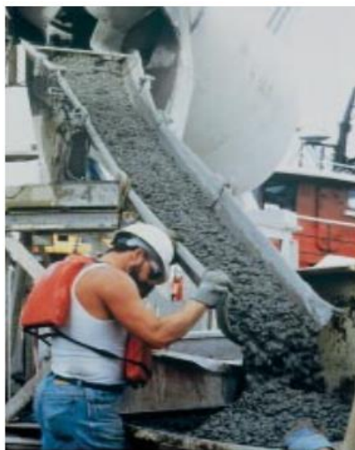
Figura 5. El concreto debe fluir sin segregación
