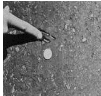
Figura 4. Agrietamiento en bloque.
