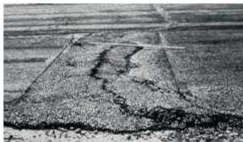
Figura 19. Desprendimiento de agregados.
