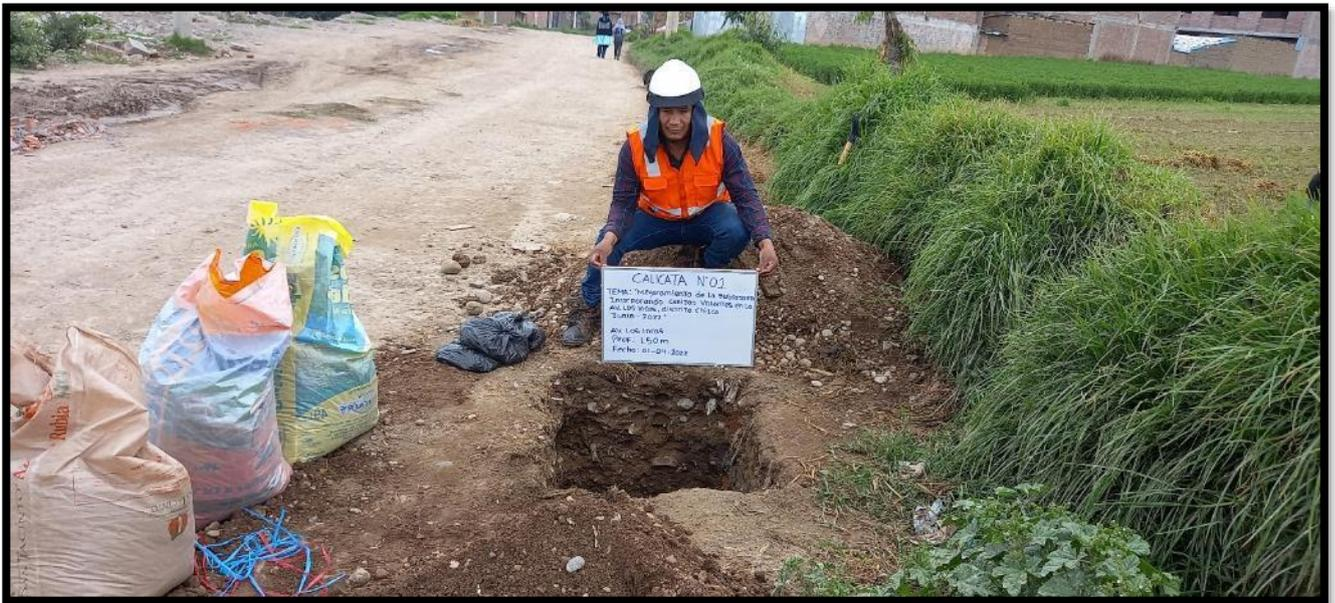
**Fotografía 5:** Excavación de la calicata C-01
