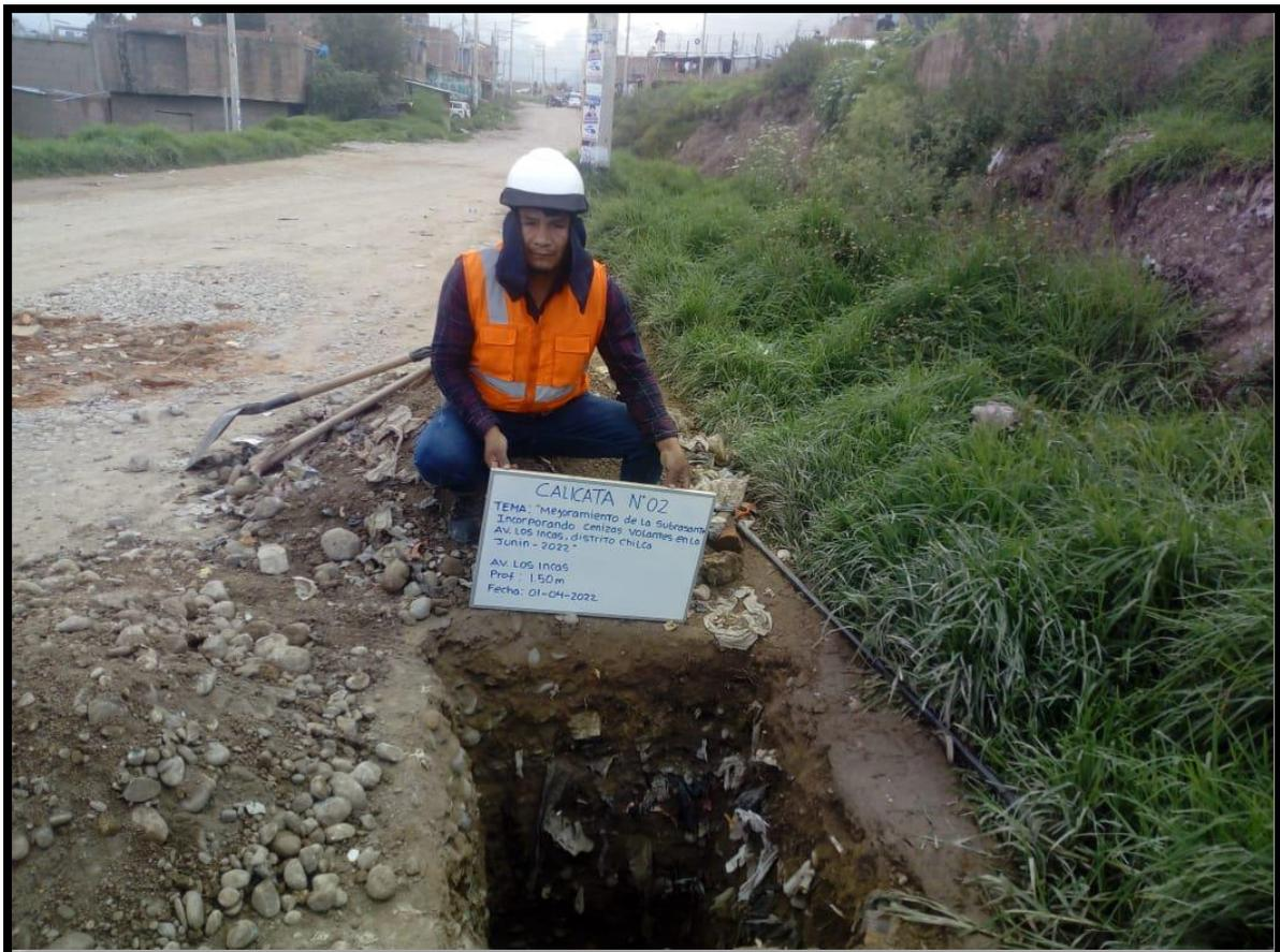
**Fotografía 6:** Excavación de la calicata C-02
