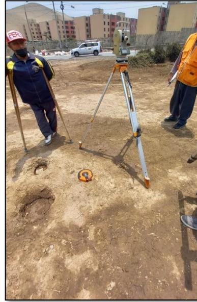
Fotografía 5. Levantamiento topográfico.      Fotografía 6. Teodolito y cinta métrica.
