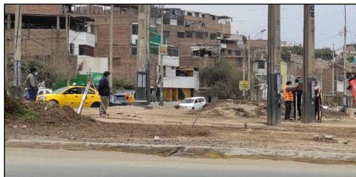
*Figura 3.* Levantamiento topográfico con teodolito.
