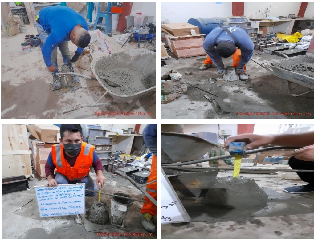
Figura 37. Ensayo de asentamiento del concreto fresco (SLUMP)
