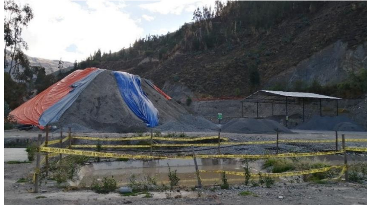
Figura 2: Agregado cubierto para protección de lluvias
