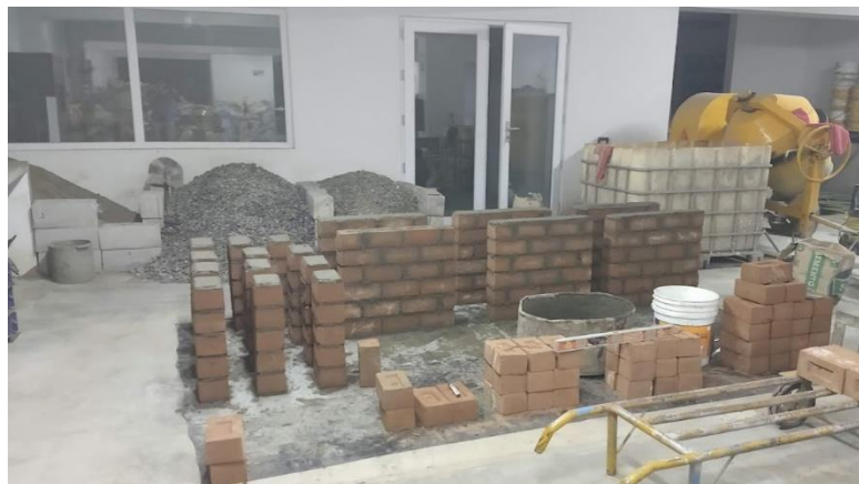
Fotografía 21. Elaboración de los muretes y pilas.
