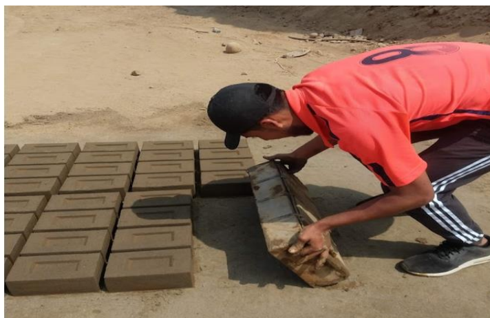
Fotografía 13. Colocación al suelo del ladrillo arcilla en el molde.
