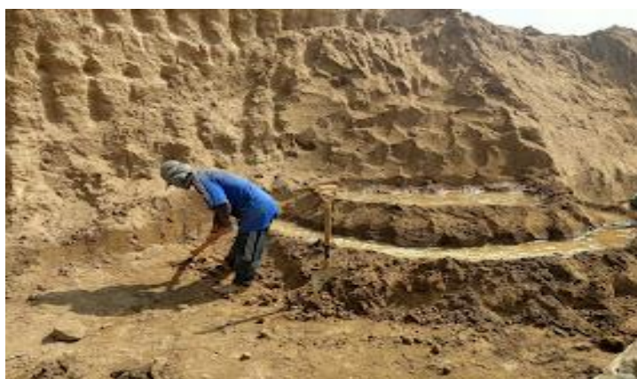
Fotografía 5. Preparación de la mezcla arcilla.
