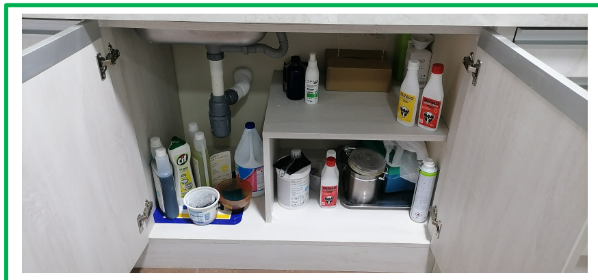
Figura 18. Área de almacén
