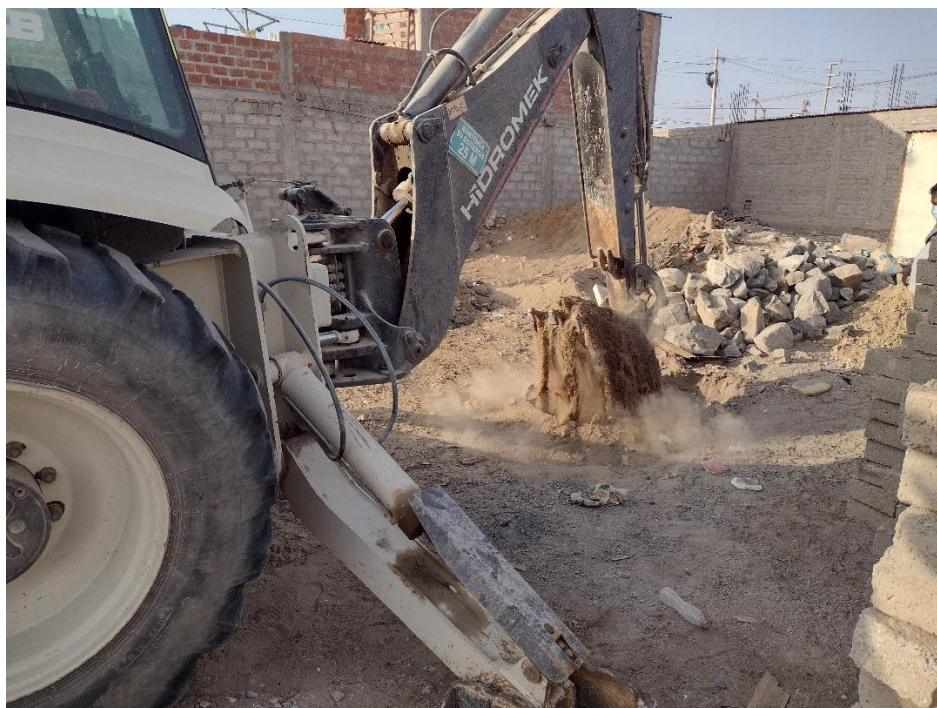
Figura 81 Excavación de calicata con maquinaria. Elaboración propia
