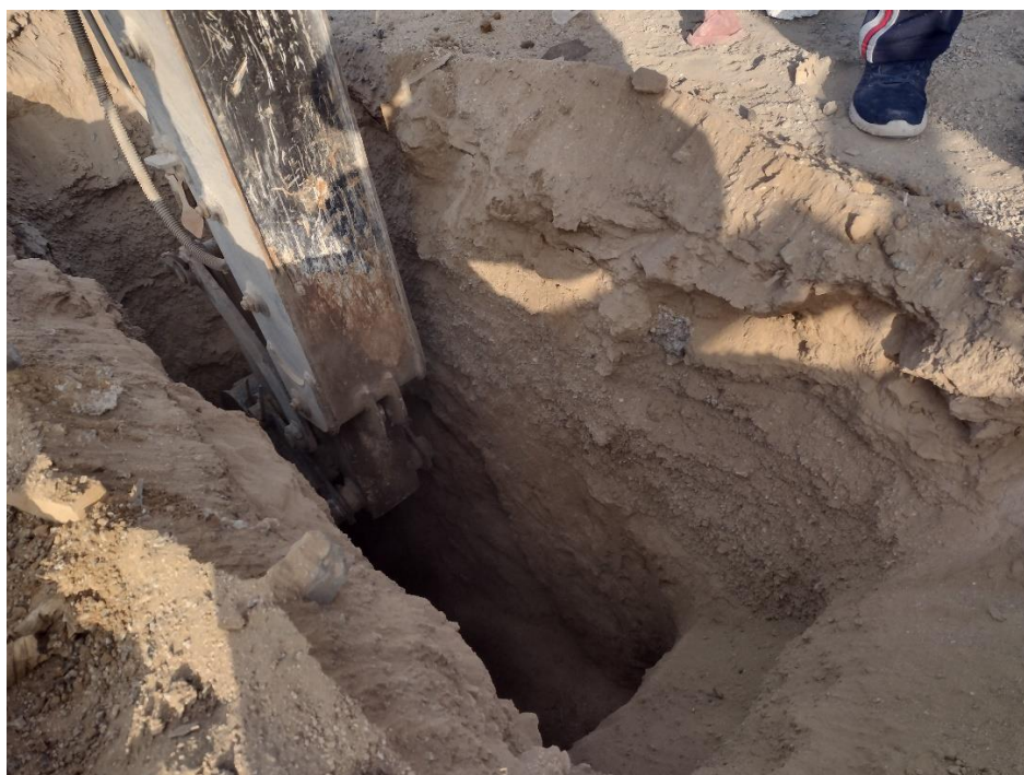
Figura 82 Excavación de calicata con maquinaria. Elaboración propia
