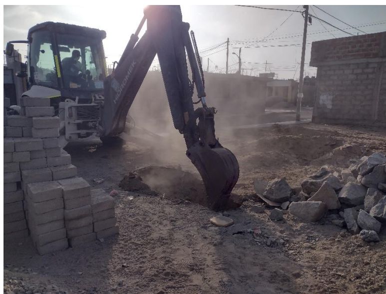
Figura 21 Excavación de calicata con maquinaria. Elaboración propia
