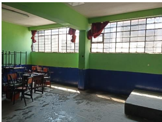
Figura 31. Aula del Pabellón A de la institución educativa.
