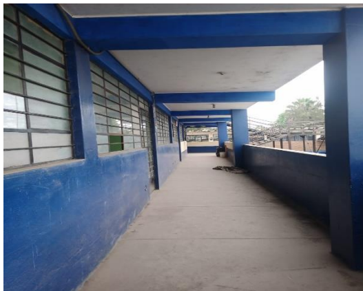
Figura 7. Pasadizo Bloque "A" de la institución educativa INEI 46.
