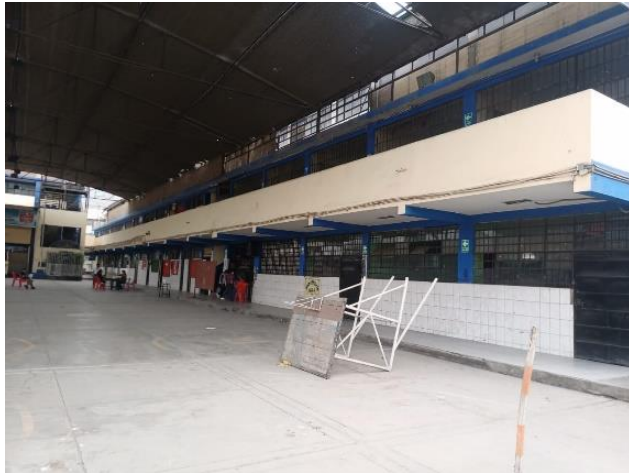
Figura 38. Cubierta Plana, Pabellón A.
