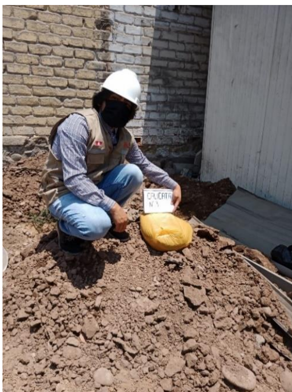
Figura 22. Muestra de calicata 2.
