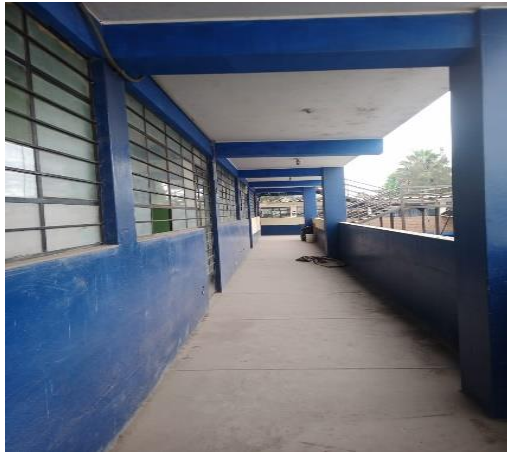
Figura 39. Balcón Pabellón A.
