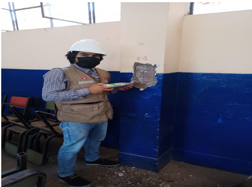
Figura 3. Ensayo de Esclerometría en columna c-1.
