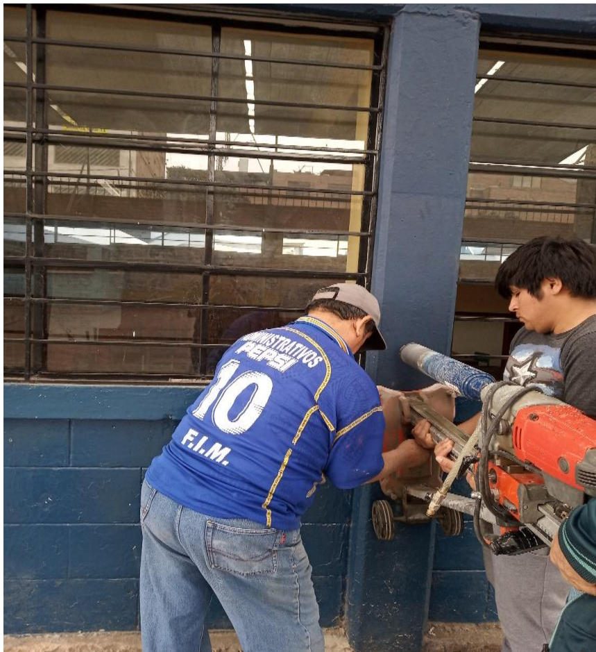
Figura 2. Extracción de testigos con diamantina.
