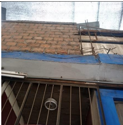
Figura 9. Exposición del acero a la intemperie.
