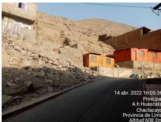
Figura 1. Deslizamiento de rocas que llegaron hasta las veredas (Elaboración propia)
