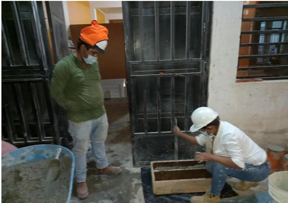
FOTO N.º 12: relleno del molde de viga de dimensiones normalizadas, en tres capas apasionadas con 25 de golpes de Varilla
