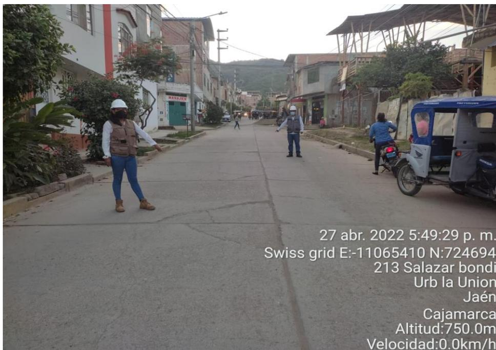
FOTO N.º 06: Fisuras con orientación predominante perpendicular al eje del pavimento en Calle. Salazar Bondy en la Ciudad de Jaén
