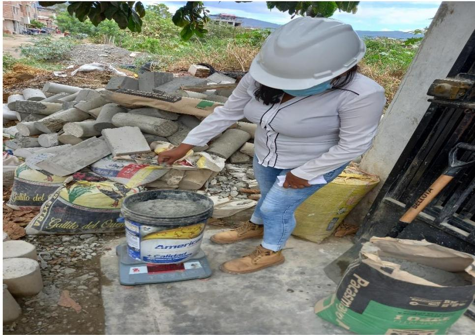
FOTO N.º 09: Pesando los Materiales: AG,AF y Cemento Para Los Ensayos de Probetas Cilíndricas y Vigas.
