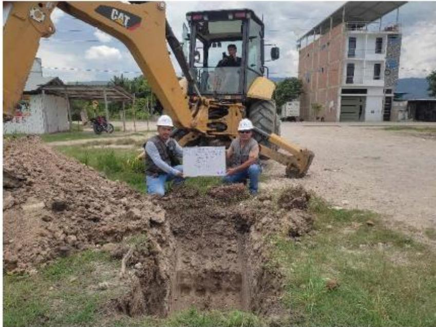
**FOTOGRAFIA 07:** Muestra la ubicación y estratigrafía de la calicata C – 07 del proyecto: "Diseño De Infraestructura Vial Urbana Para La Transitabilidad Vehicular Y Peatonal Del Centro Poblado San Agustín, Bellavista, Jaén, Cajamarca".
