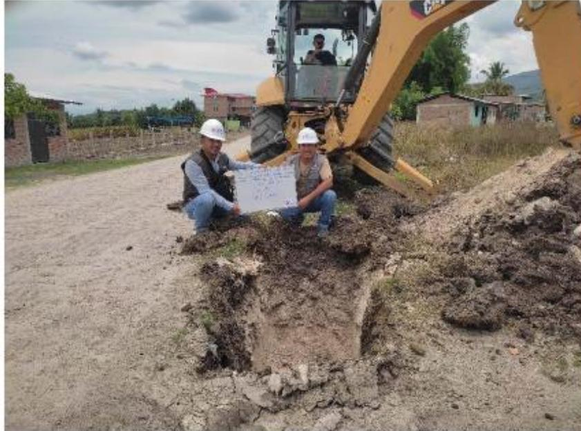
**FOTOGRAFIA 03:** Muestra la ubicación y estratigrafía de la calicata C – 03 del proyecto: "Diseño De Infraestructura Vial Urbana Para La Transitabilidad Vehicular Y Peatonal Del Centro Poblado San Agustín, Bellavista, Jaén, Cajamarca".
