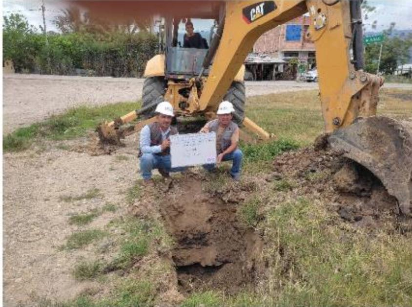
**FOTOGRAFIA 01:** Muestra la ubicación y estratigrafía de la calicata C – 01 del proyecto: "Diseño De Infraestructura Vial Urbana Para La Transitabilidad Vehicular Y Peatonal Del Centro Poblado San Agustín, Bellavista, Jaén, Cajamarca".
