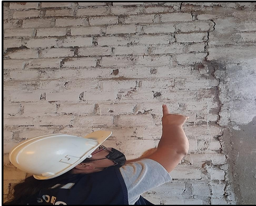
Fotografía 01. Vivienda N°017 del lote 005
