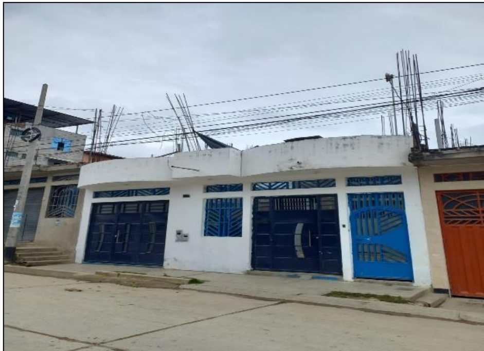
Figura 41. Vivienda con configuración en planta regular
