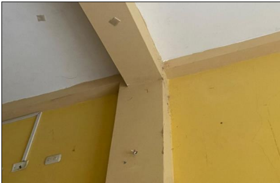
Figura 4. Vivienda N° 001 y N°002 del lote 007, con excelente confinamiento de muros portantes.
