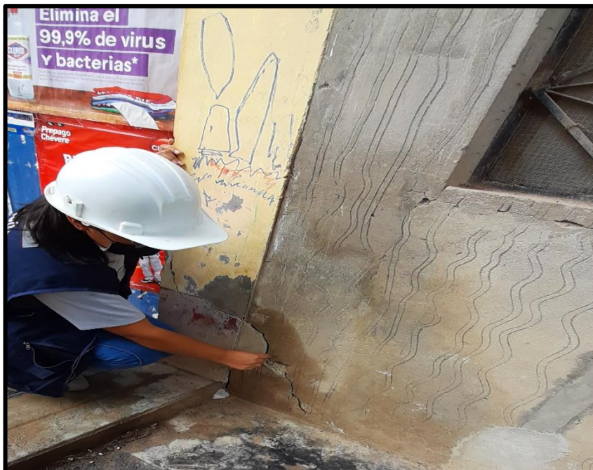
Fotografía 02. Vivienda N°019 del lote 005
