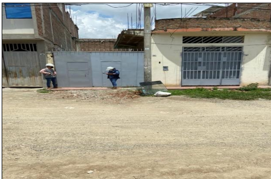
Figura 16. Vivienda N°009 del lote 006, sección de muros de la vivienda es continua en el primer piso
