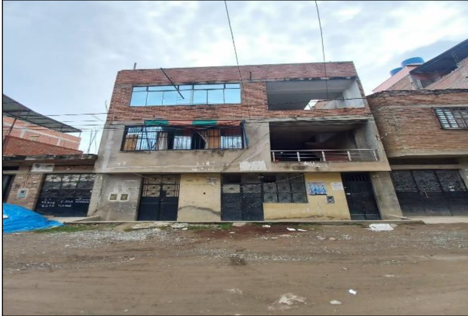
Figura 42. Vivienda con configuración en elevación regular
