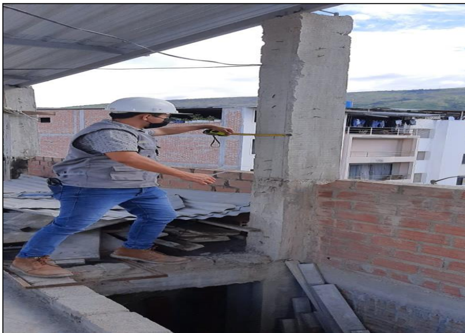
Figura 22. Vivienda N°013 del lote 005, vivienda con muros de tabiquería bien conectados al sistema resistente
