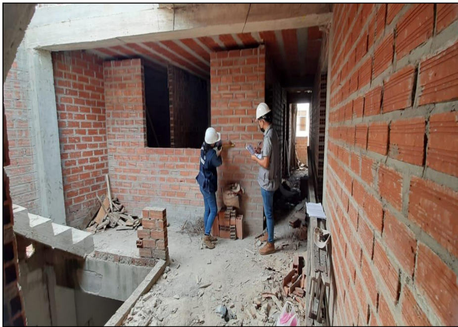
Figura 48. Vivienda con elementos estructurales es condiciones óptimas
