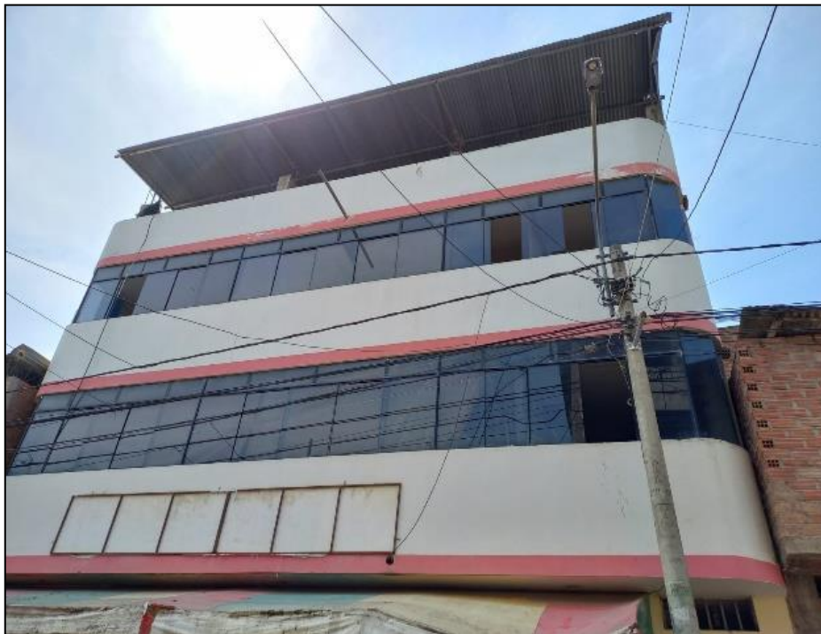
Figura 43. Vivienda con configuración en elevación regular
