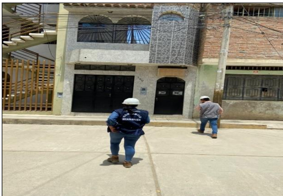
Figura 23. Vivienda N°002 del lote 005, vivienda con balcón bien conectado al sistema resistente
