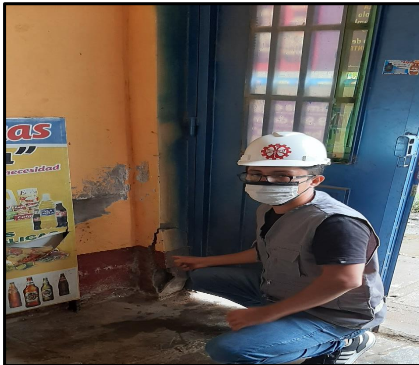
Fotografía 03. Vivienda N° 021 del lote 006
