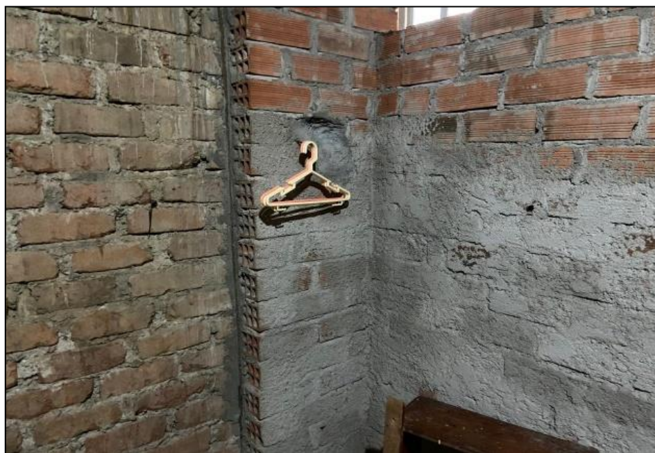
Figura 7. Vivienda N°014 del lote 005, muro de ladrillo con piezas no homogéneas
