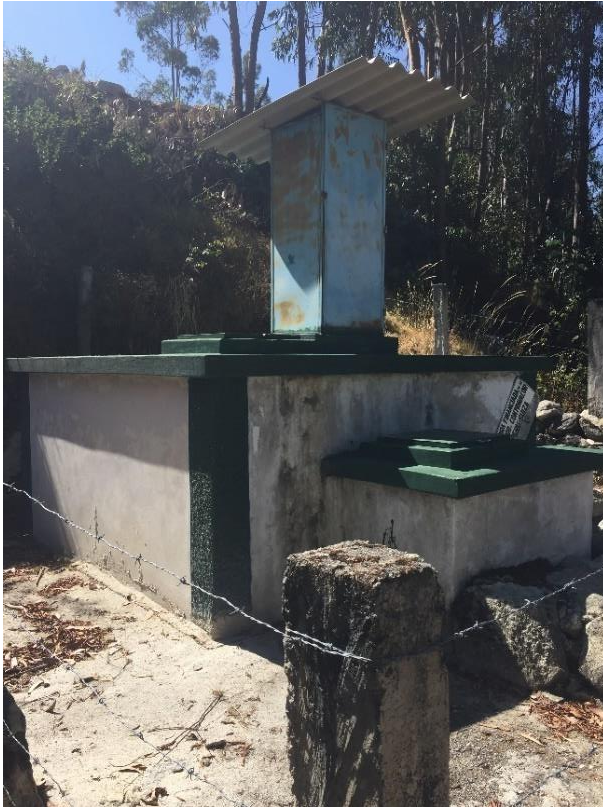
Figura 4. reservorio de Arguay
