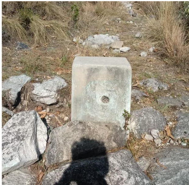
Figura 3. Tubo rompe carga
