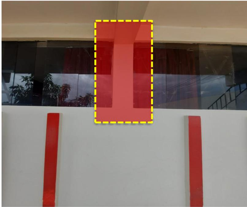
Figura 20 Columna corta en Eje 2, Pabellón 101
