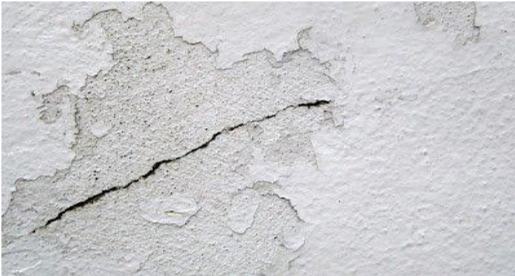
Figura 2: Fotografía de fisuras en columnas
