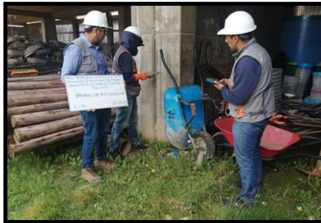
Figura 21: Ensayo de esclerómetro – columnas C-43
