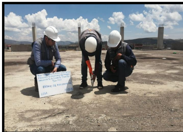
Figura 16: Ensayo de esclerómetro - losa
