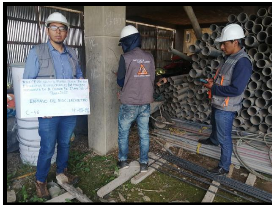
Figura 19: Ensayo de esclerómetro – columnas C-40
