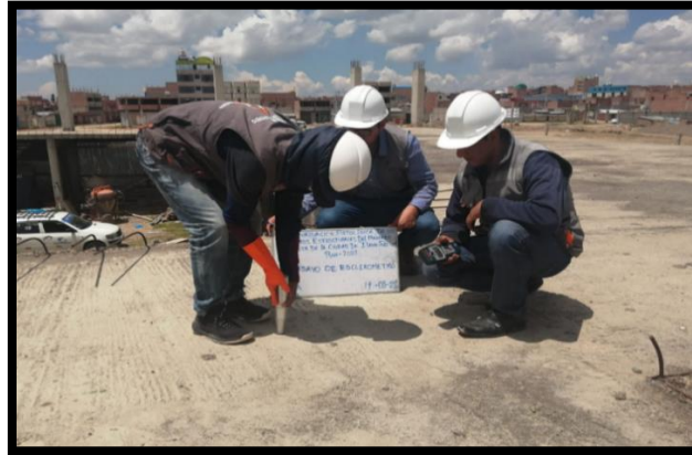
Figura 17: Ensayo de esclerómetro - losa
