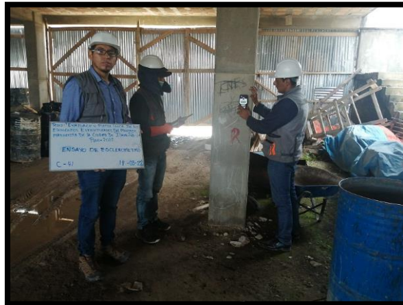
Figura 20: Ensayo de esclerómetro – columnas C-41
