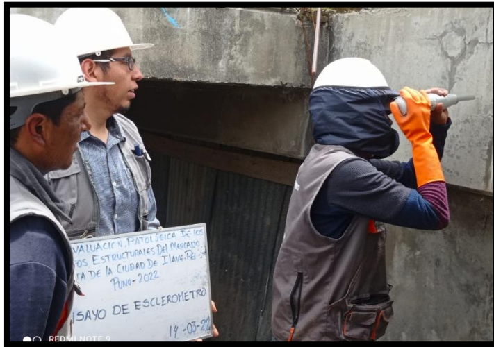
Figura 15: Ensayo de esclerómetro – vigas
