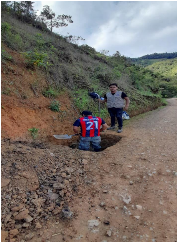
Figura 40: Comienzo de excavación de calicata 1
