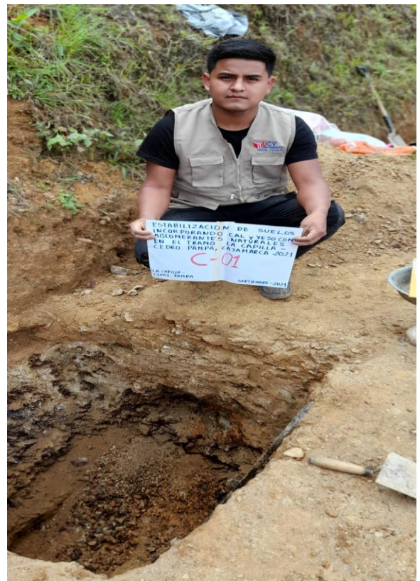
Figura 41: Calicata nº 1 en el km 0 + 360
