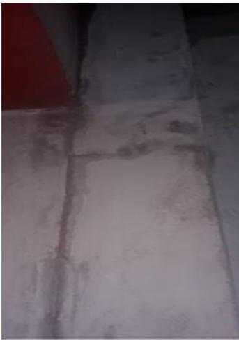
**Ilustración 11: VIVIENDA 4- SE APRECIA MOHO EN COLUMNA**
