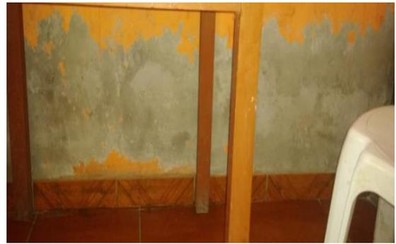
**Ilustración 20: VIVIENDA 7 SE OBSERVA EFLORESCENCIA Y DESPRENDIMIENTO DE PINTURA**
