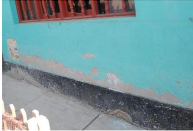
**ILUSTRACIÓN 10: VIVIENDA 4-TRES ESTRELLAS - CALLE LOS GERANOS MZ F LT 22- APRESIAMOS DESPRENDIMIENTO Y EROSION**
