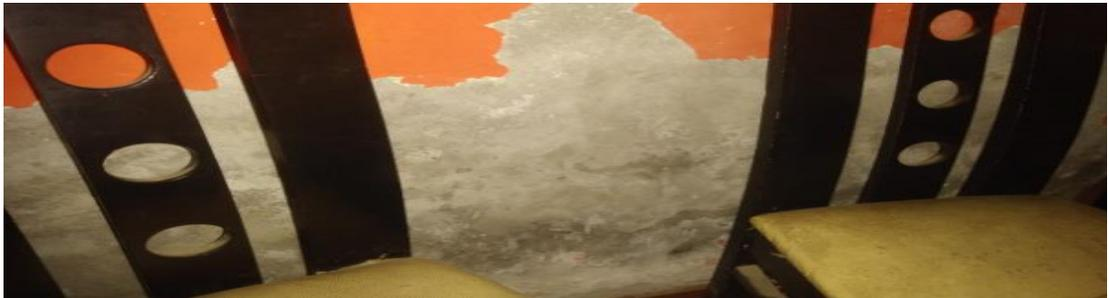
**ILUSTRACIÓN 30: VIVIENDA 11 – SE OBSERVA EFLORESCENCIA EN LA SALA**
