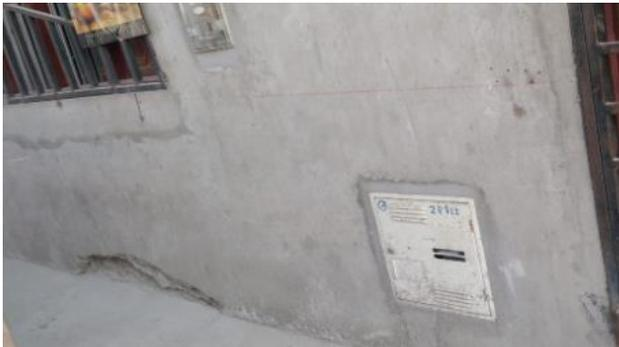
**Ilustración 9: VIVIENDA 3- SE OBSERVA EROSION Y PRESENCIA DE EFLORESCENCIA**
