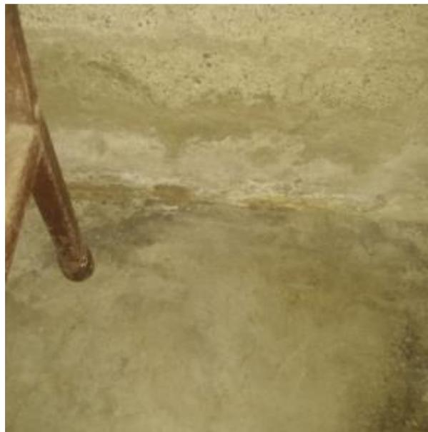
**ILUSTRACIÓN 28:VIVIENDA 10 EROSION Y MOHO EN PAREDES**
