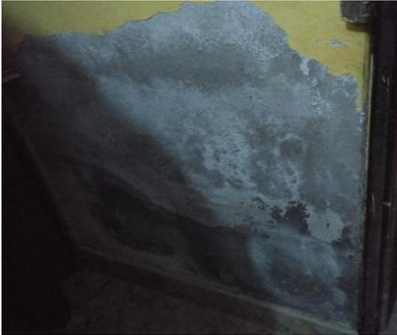
**Ilustración 15: VIVIENDA 5-SE OBSERVA EFLORESCENCIA SEVERA EN EL MURO**
