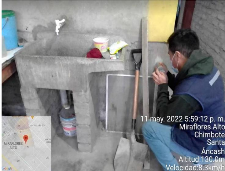
**ILUSTRACIÓN 43: ENSAYO DE ESCLEROMETRIA VIVIENDA N°02**
