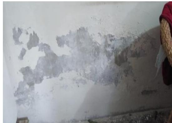
**Ilustración 14: VIVIENDA 5- tres estrellas - calle los jardines mz L lt 26 – SE APRECIA EFLORESCENCIA LEVE EN FACHADA**
