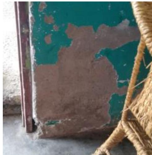
**Ilustración 25: VIVIENDA 9: OBSERVAMOS EL DESPRENDIMIENTO Y EROSION EN LA SALA**
