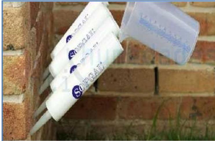
Figura 40: Inyección de Barrera Capilar Líquida Sopgal
