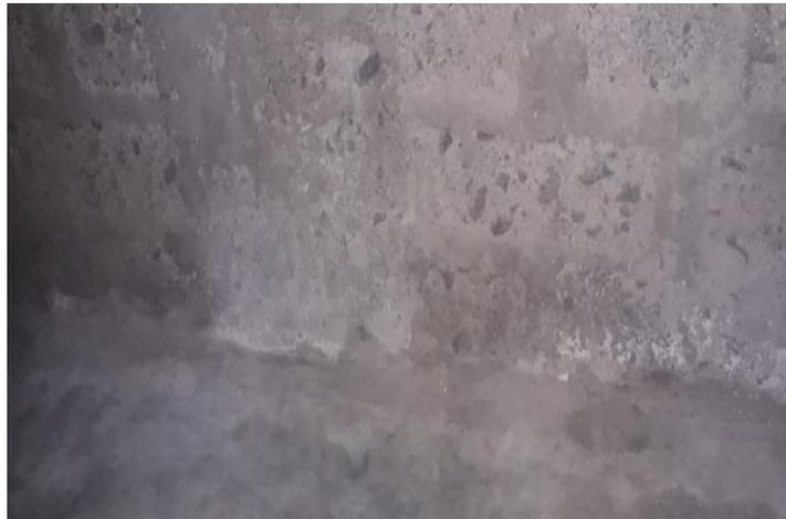
**Ilustración 12: VIVIENDA 4 SE APRECIA EROSION EN LOS MUROS**
