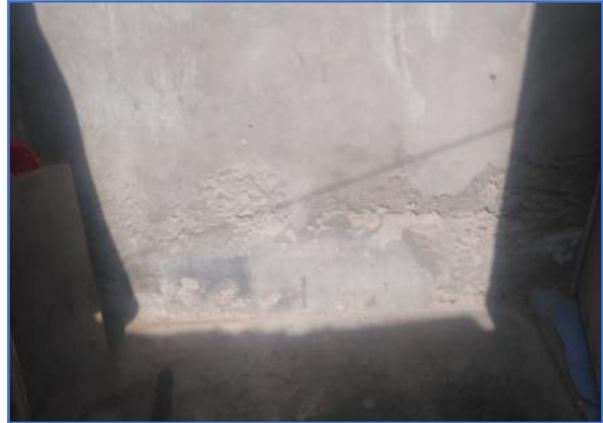
**Ilustración 2: VIVIENDA N°1 – PRESENCIA DE EROSION EN LOS MUROS**
