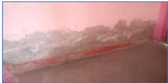
**Ilustración 4: VIVIENDA N°1 – DESPRENDIMIENTO DE PINTURA**
