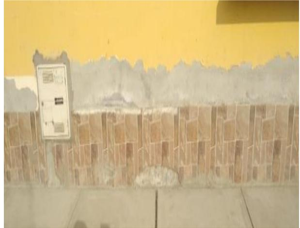
**ILUSTRACIÓN 29:VIVIENDA 11-TRES ESTRELLAS - PSJ SONARES MZ S' LT 25 – SE VE EFLORESCENCIA Y EROSION EN FACHADA**
