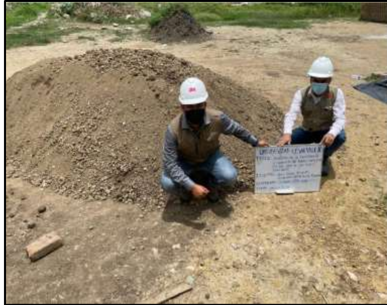
Figura N° 05: Material arenoso en cantera del sector fila alta.
