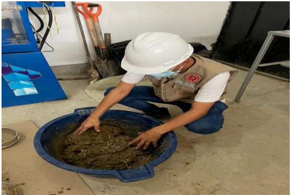
FOTOGRAFÍA N°20: Preparación de adobes con % de incorporación, por parte del Tesista Cubas.
