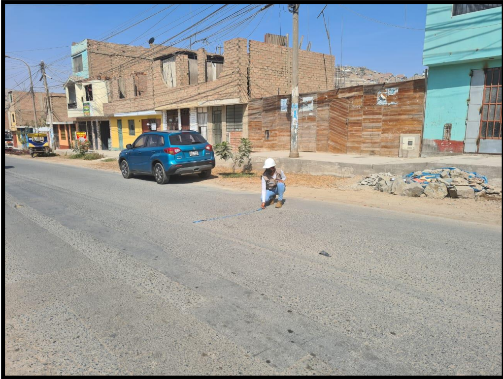
Medición de la calzada
