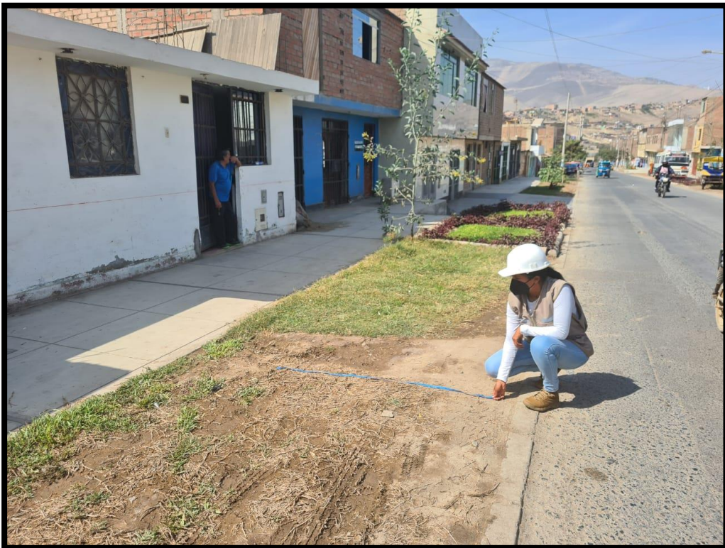
Medición de berma lateral derecha
