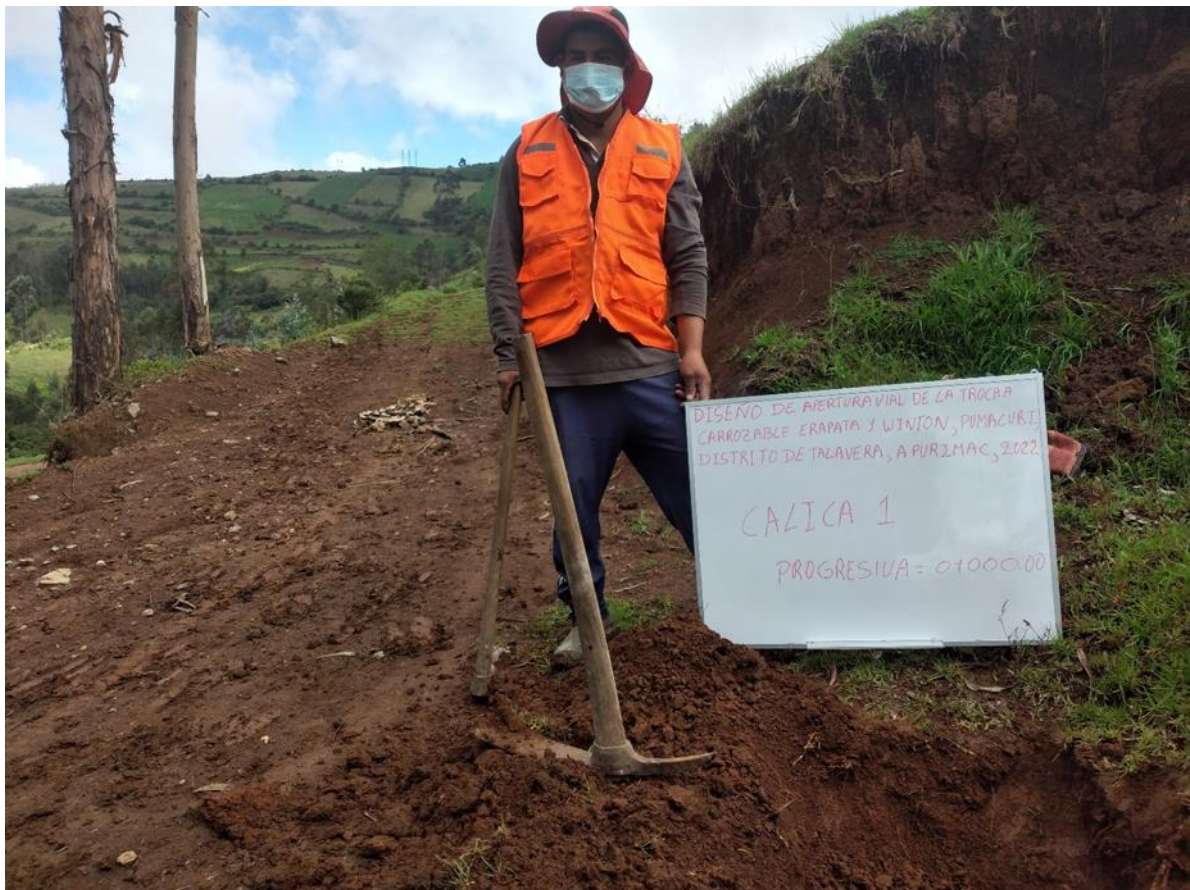
Figura 19: en la figura se muestra al personal mostrando la excavación de la calicata 1 que está en la progresiva 0+000.00
