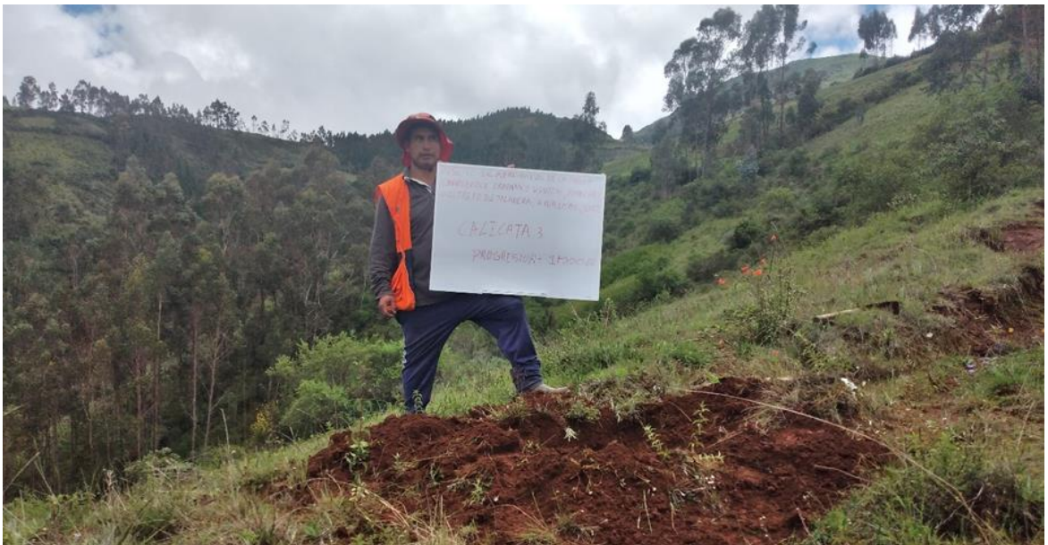
Figura 21: en la figura se muestra al personal mostrando la excavación de la calicata 3 que está en la progresiva 1+000.00
