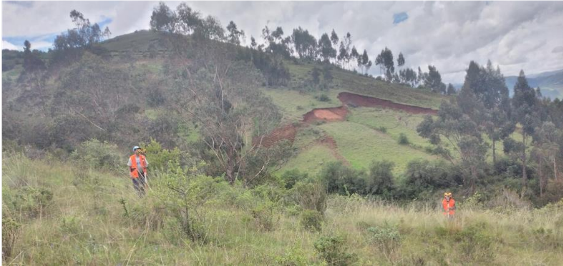
Figura 18: en la figura se muestra un deslizamiento de tierra provocado por las fuertes lluvias propias de la zona
