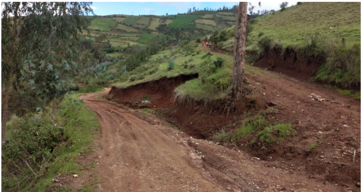
Figura 13: en la figura se muestra el ramal de inicio de carretera que existe su plataforma, en 300 metros
